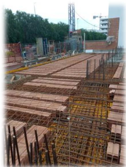
Le strutture portanti di fondazione dell'intero edificio saranno costituite da un reticolo di travi rovesce di adeguate dimensioni che poggeranno su strato di magrone precedentemente steso sul terreno. Dalle
