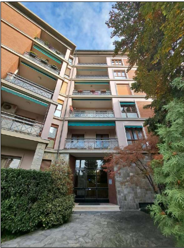
Vista Ingresso al fabbricato
