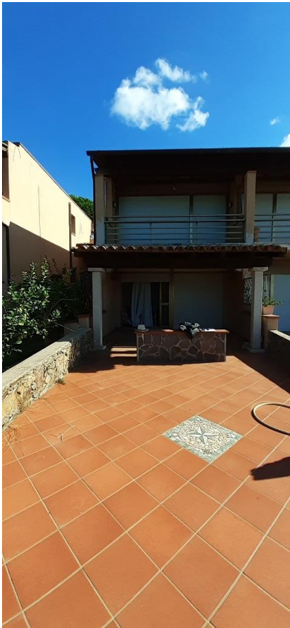
Figura 10: Veranda di proprietà a nord
