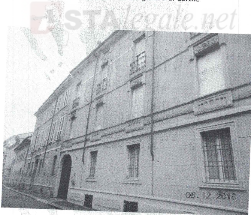
foto 12: prospetto su via Garibotti
