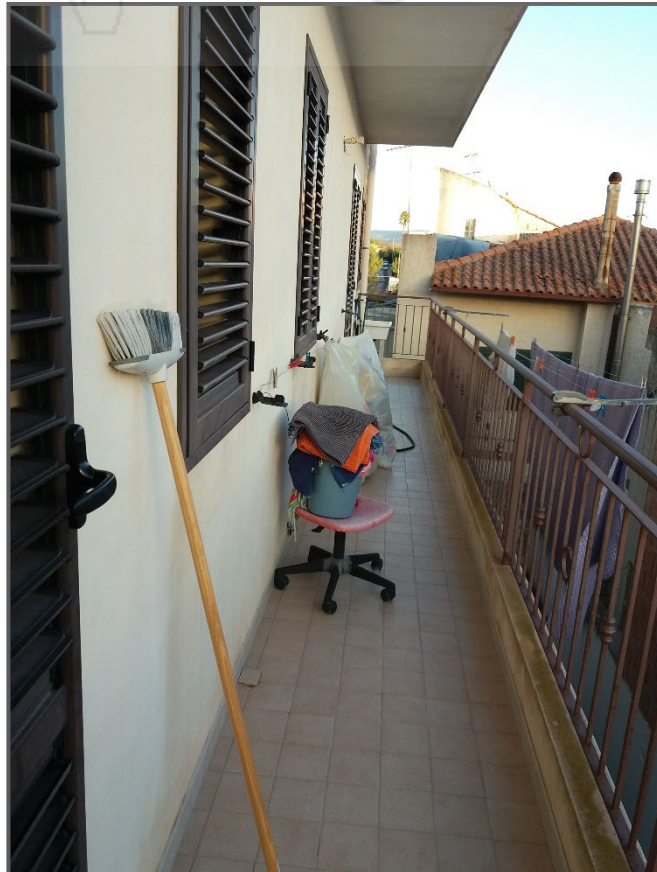
Foto 16: Balcone retro strada
