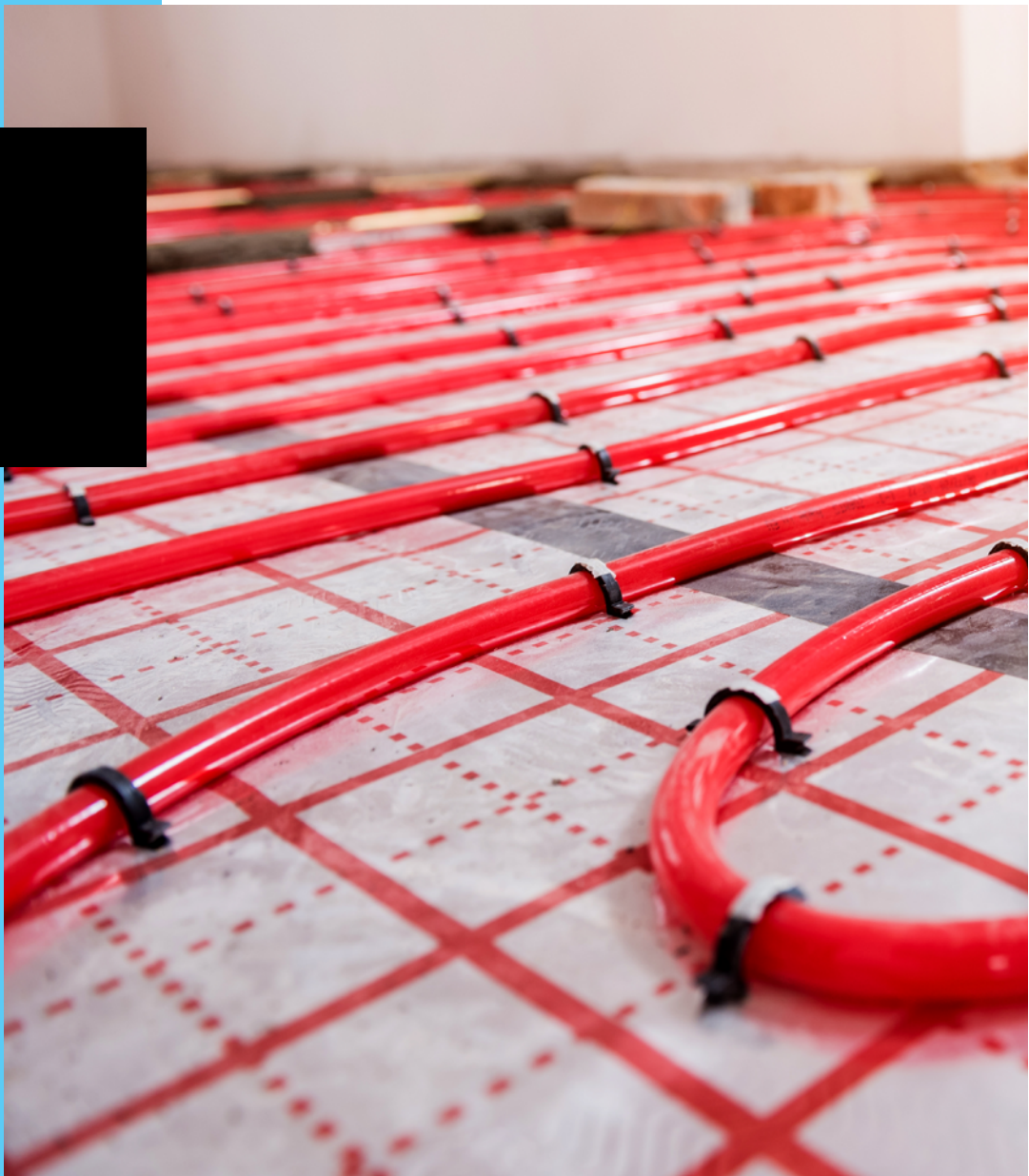
Riscaldamento a pavimento
