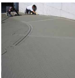
D1 - d _ Rampa corsello
