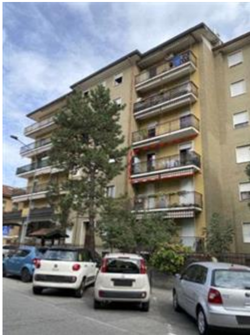
Prospetto ovest su via Verdi - Appartamento piano secondo (Part. 1253 Sub. 27)
