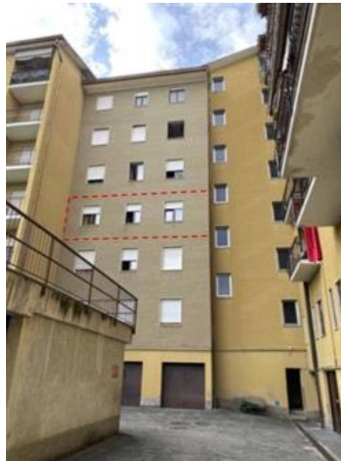
Prospetto est - Appartamento piano secondo (Part. 1253 Sub. 27)
