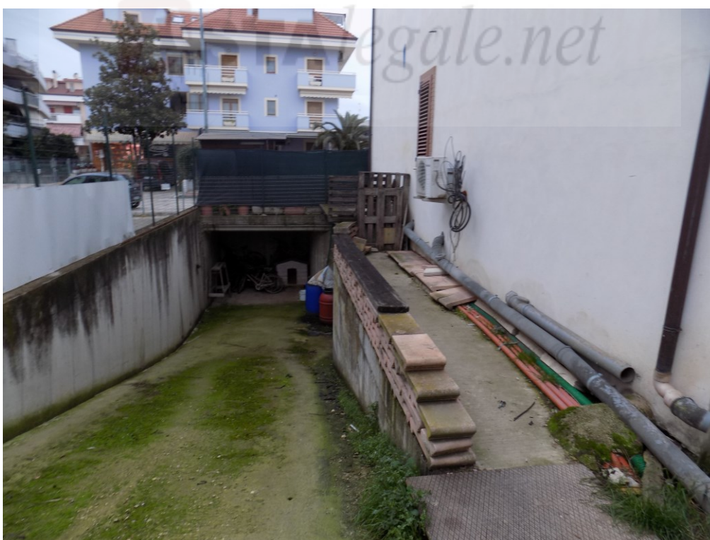
Rampa di Accesso al piano interrato – visibile la chiusura dello spazio di manovra sotto e l'aiuola da rinterrare (lato ovest)
