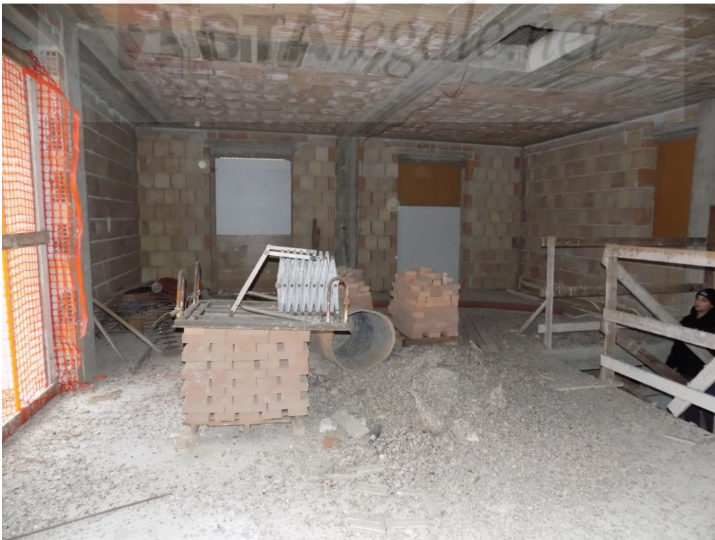
Piano Secondo – stato attuale - panoramica
