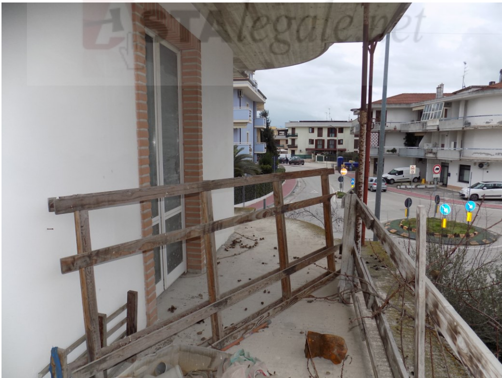
Piano Primo – stato attuale - balconi
