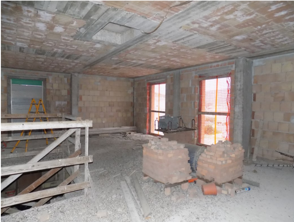
Piano Secondo – stato attuale - panoramica
