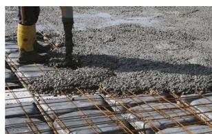
Il solaio a piano di campagna verrà realizzato mediante getto di cappa in calcestruzzo, armato con rete elettrosaldata.
