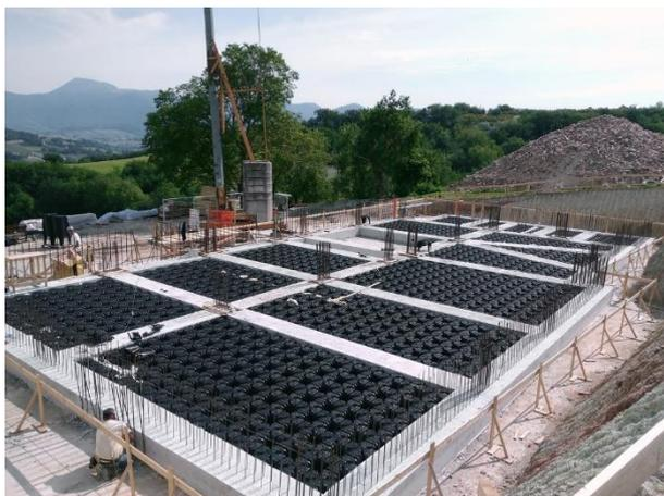
Le fondazioni saranno di tipo continue a travi rovesce, composte da getto di calcestruzzo con classe di esposizione XC1/XC2 C25/30 (Rck 30 N/mm<sup>2</sup>) ed armato con ferri e staffe.
