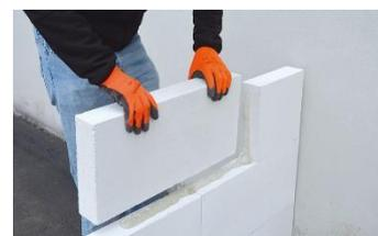
Le tramezzature saranno costituite da blocchi autoclavati in calcestruzzo areato, anche ad essi verrà applicato uno strato di intonaco di finitura del tipo premiscelato dello spessore minimo di 1,5 cm.
