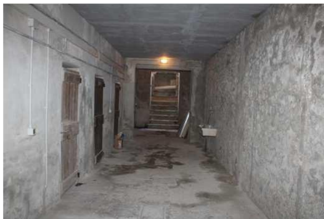
Foto 20: corridoio comune di accesso alle cantine
