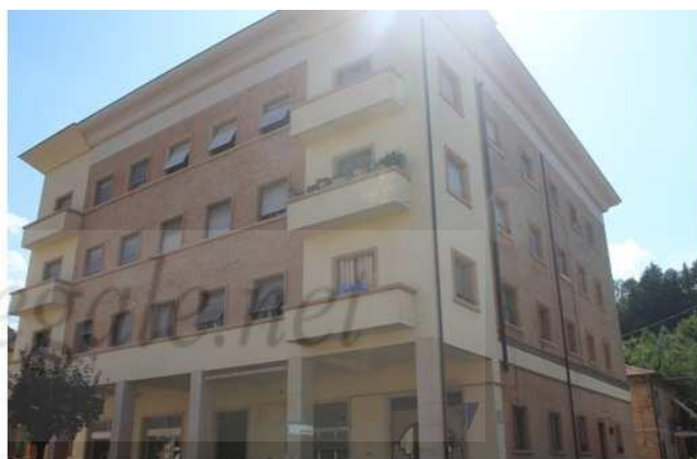
Foto 3: prospetti est e nord
