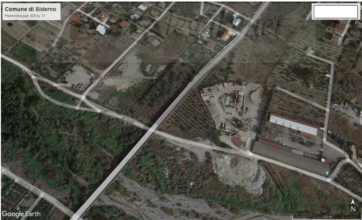
FOTO AEREA N. 2 – impianto -
