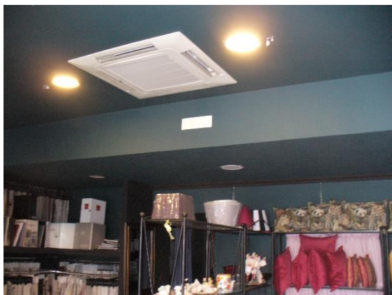
– FOTO N. 32 – zona controsoffittata –
