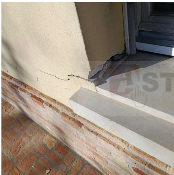
Particolare fessura su finestra est e sul marciapiede
