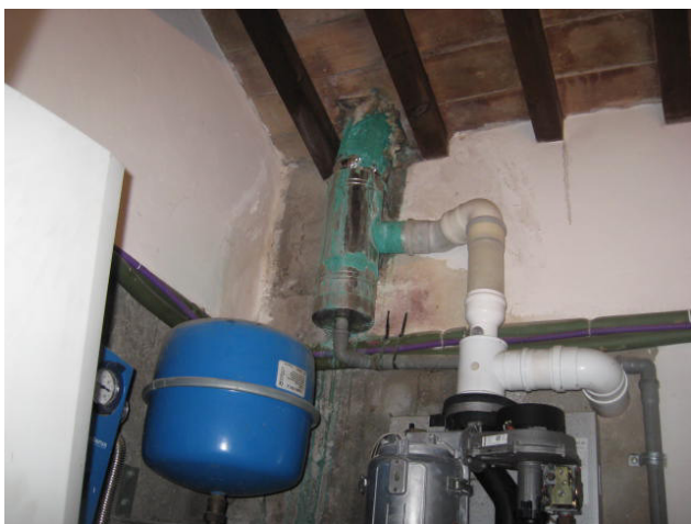
Zona centrale termica nel manufatto autonomo (ovest) e bagno
