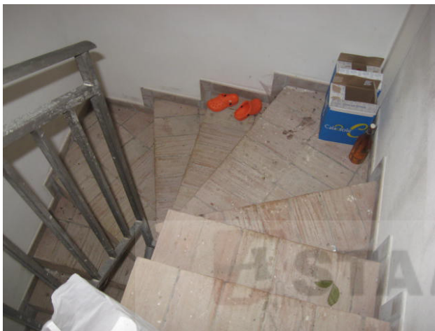
Scala accesso cantina e particolare cantina
