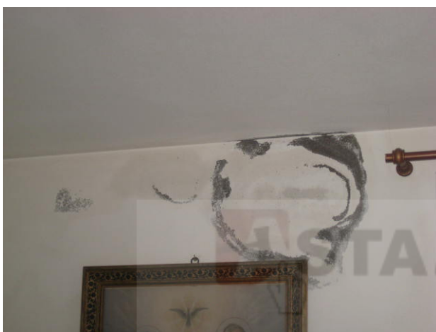
Particolare zona interessate da efflorescenzeintonaci- tinteggiature
