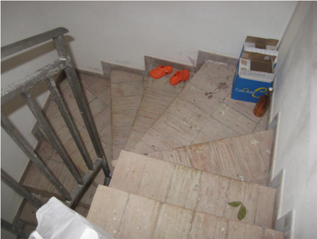
Scala accesso cantina e particolare cantina
