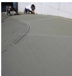
D1 - d _ Rampa corsello
