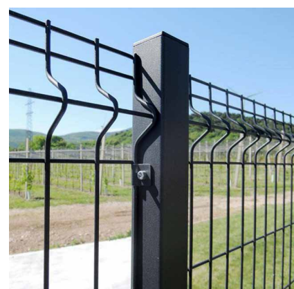
E_ Dettaglio recinzione perimetrale
