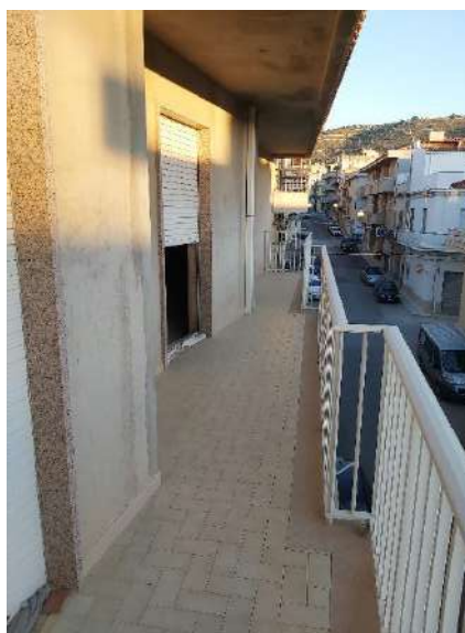
Foto n. A.36 e A.37: Balcone su Via Tolomeo (Sub 5)
