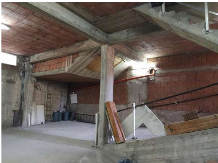
Foto n. A.11 : Interni del Locale (Sub 2)
