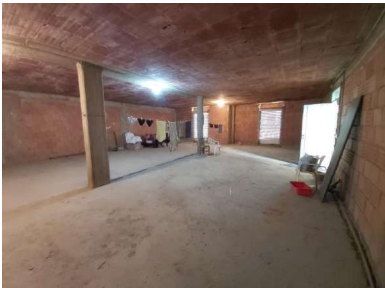
Foto n. A.34: Interni del Locale (Sub 5).
