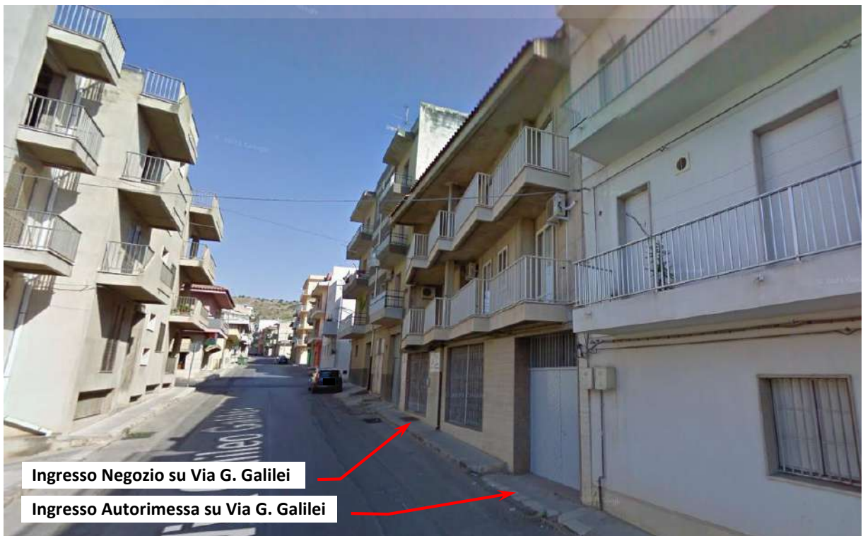
Figura n. A.06 : Foto Prospetto Edificio su Via Galileo Galilei.
