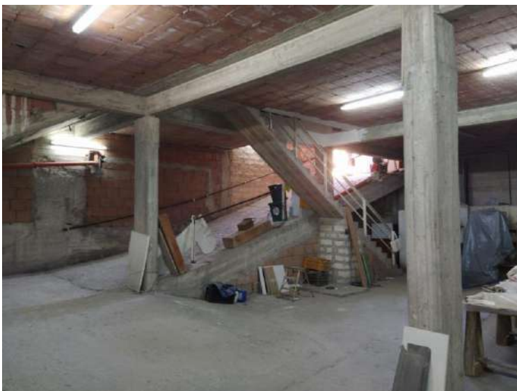
Foto n. A.10 : Interni del Locale (Sub 2)
