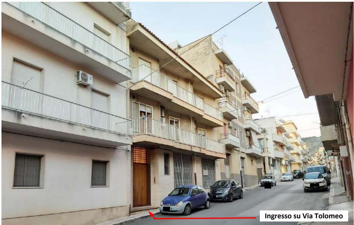
Figura n. A.05 : Foto Prospetto Edificio su Via Tolomeo.
