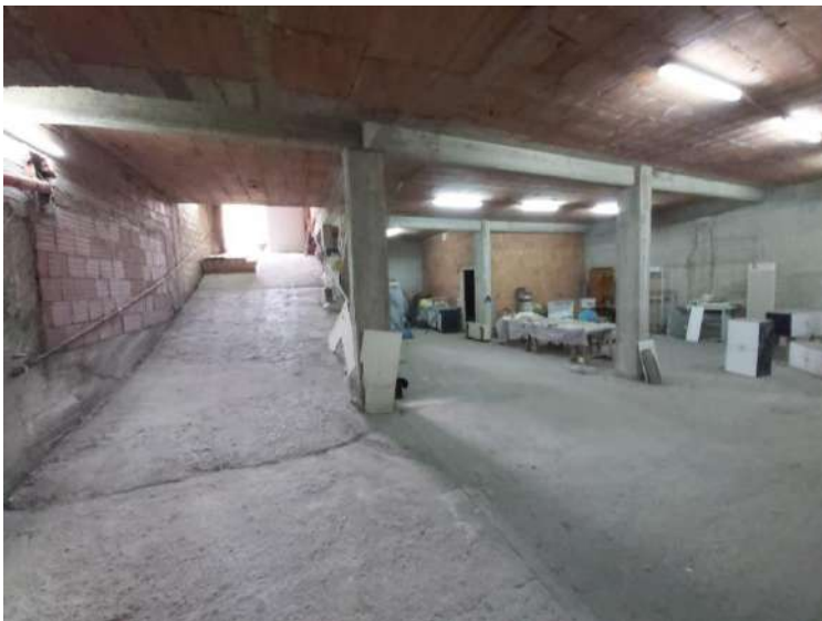
Foto n. A.08 : Interni del Locale (Sub 2)
