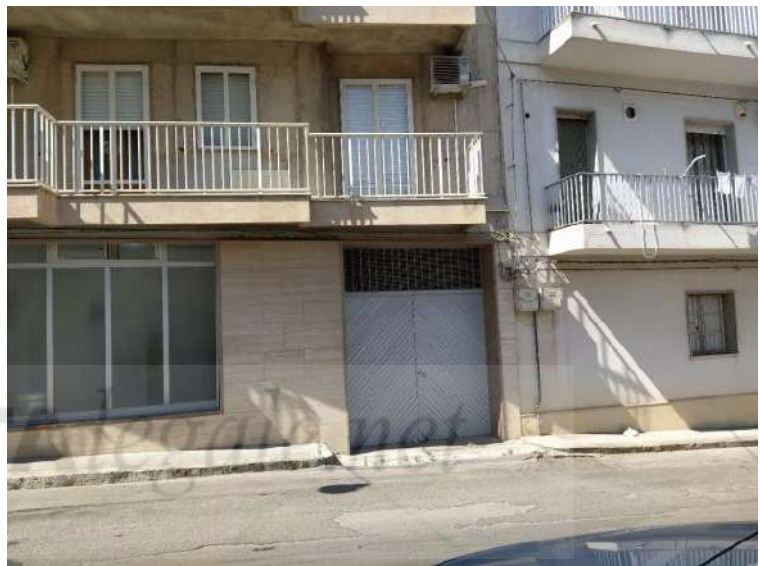
Foto n. A.07 : Ingresso al locale costituente il Sub 2
