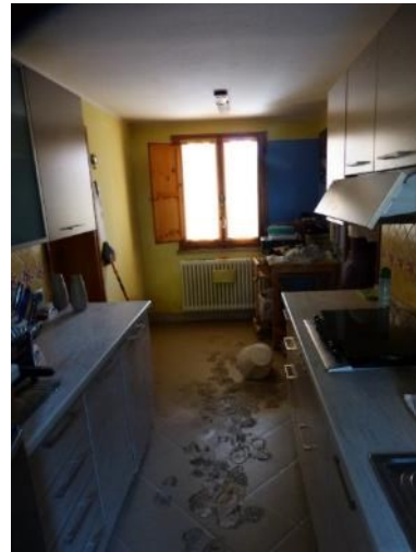
Vano lavanderia arredato a cucina
