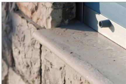
I bancali delle finestre saranno forniti e posati in opera in ISOLPIETRA, un prodotto studiato per durare all'esterno: impermeabile e traspirante; possiede inoltre un'ottima resistenza ai raggi UV. Il prodotto è trattato per rimanere impermeabilizzato entro temperature di esercizio comprese tra -35°C e +100°C.
