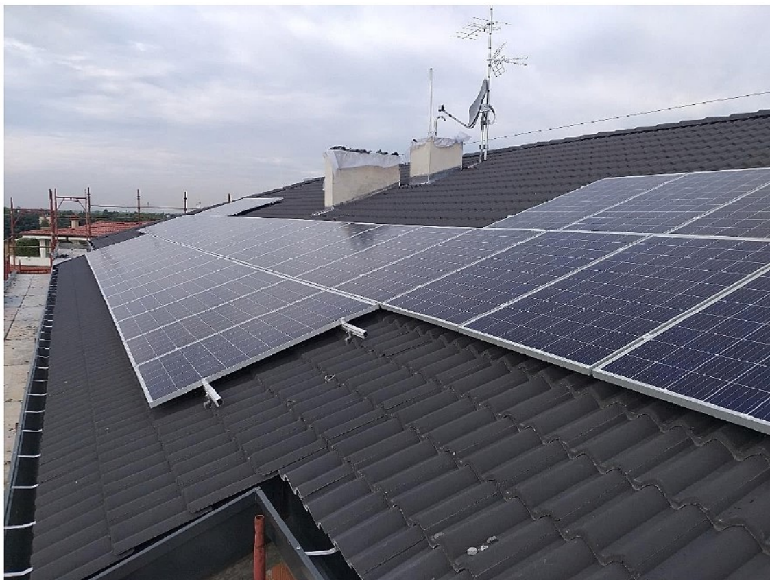
Copertura con tegole portoghesi in cotto e pannelli fotovoltaici
