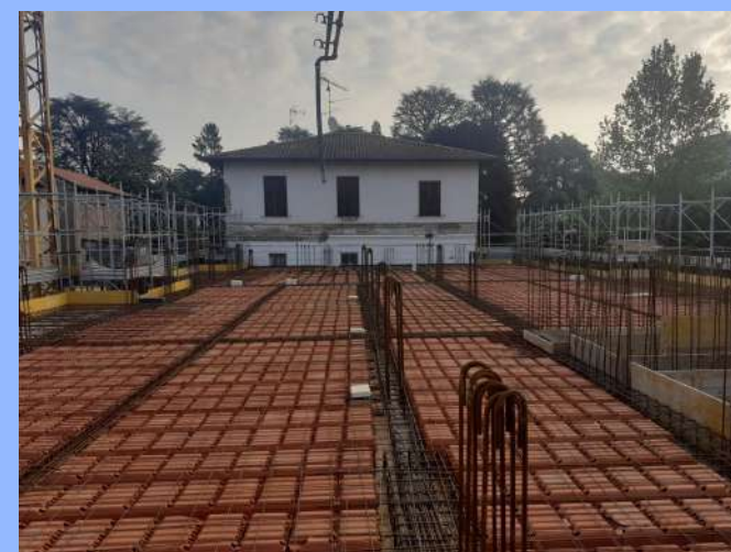
Figura 9 – Solaio laterocemento realizzato in altro cantiere
