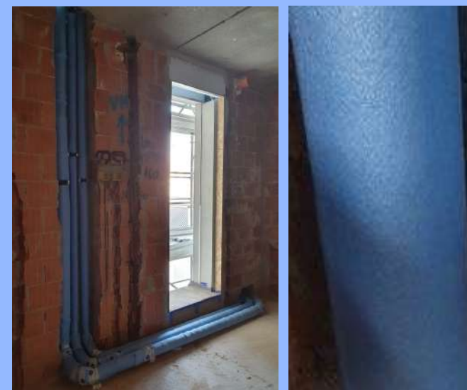
Figura 21 – Colonne montanti
