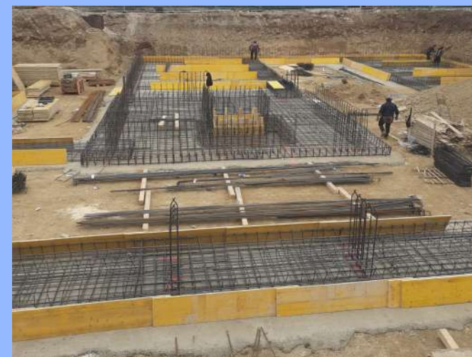
Figura 7 – Opere in C.A. eseguito in altro cantiere
