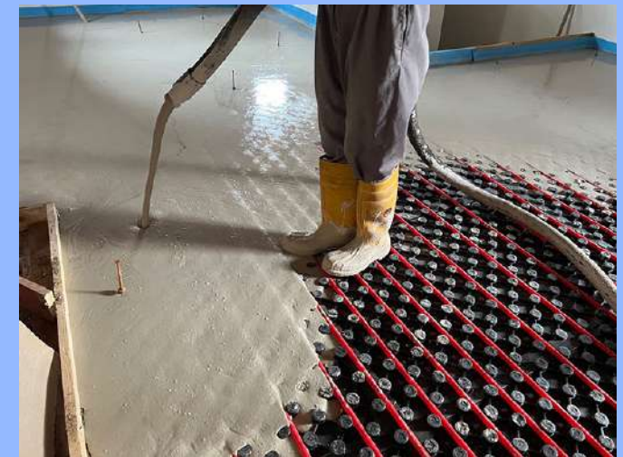
Figura 23 – Massetto radiante
