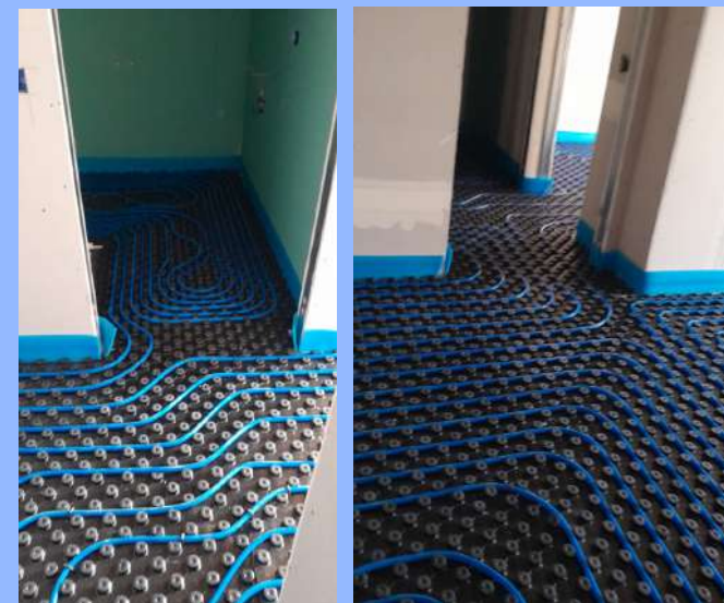
Figura 38 – Impianto radiante realizzato in altro cantiere
