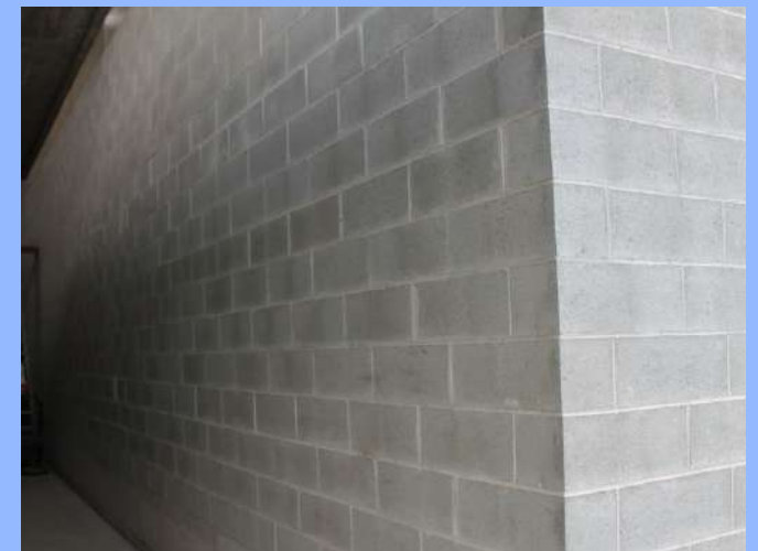
Figura 13 – Muratura blocchi faccia a vista
