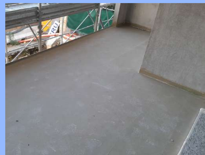
Figura 11 – Opere di impermeabilizzazione balcone eseguite in altro cantiere
