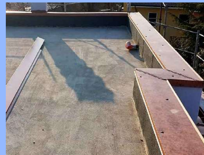
Figura 17 – Cappello in lattoneria coronamento copertura
