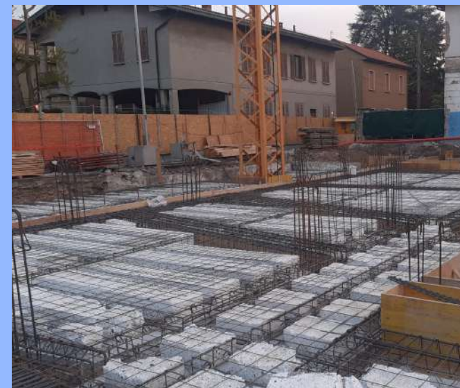
Figura 8 – Solaio predalles realizzato in altro cantiere
