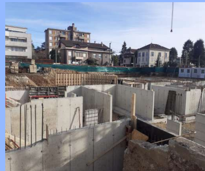
Figura 6 – Opere in C.A. eseguito in altro cantiere
