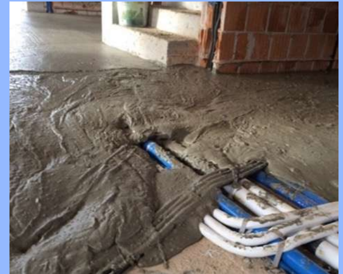
Figura 22 – Sottofondo alleggerito
