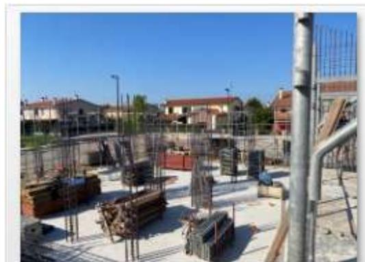
Realizzazione di travi a spessore solaio e solette in calcestruzzo, con resistenza caratteristica C 30/35, gettati con l'ausilio di casseri e casseforme, l'armatura di sostegno, le puntellazioni, il getto, la vibratura ed il disarmo, compresa la fornitura e la posa del ferro d'armatura in barre longitudinali (B450C) o staffe compreso tagli e sfridi.
