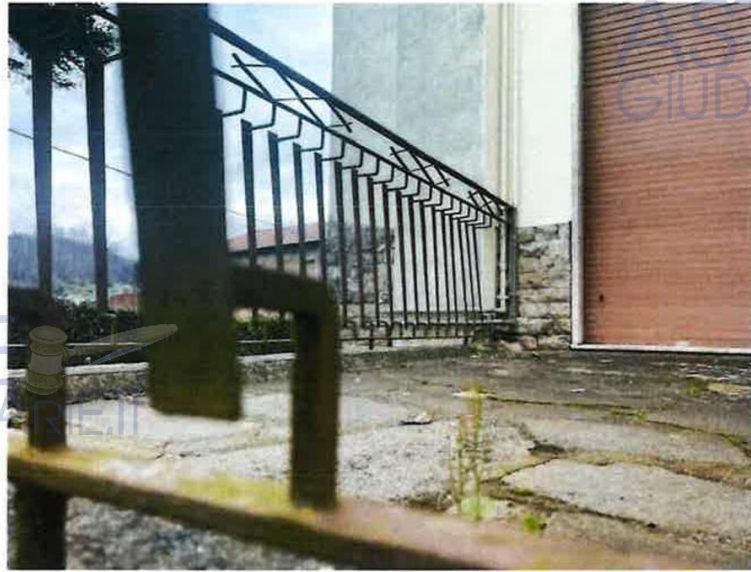
TERRAZZO LATO VIA VANNUGLI
