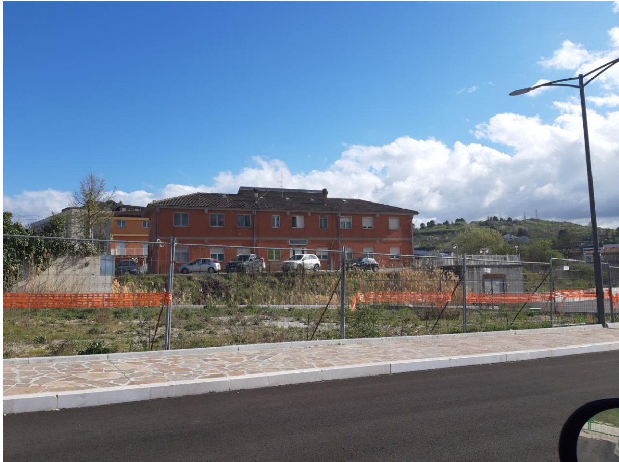
Figura 4 – Appartamento Via del Gallitello, n. 130.
