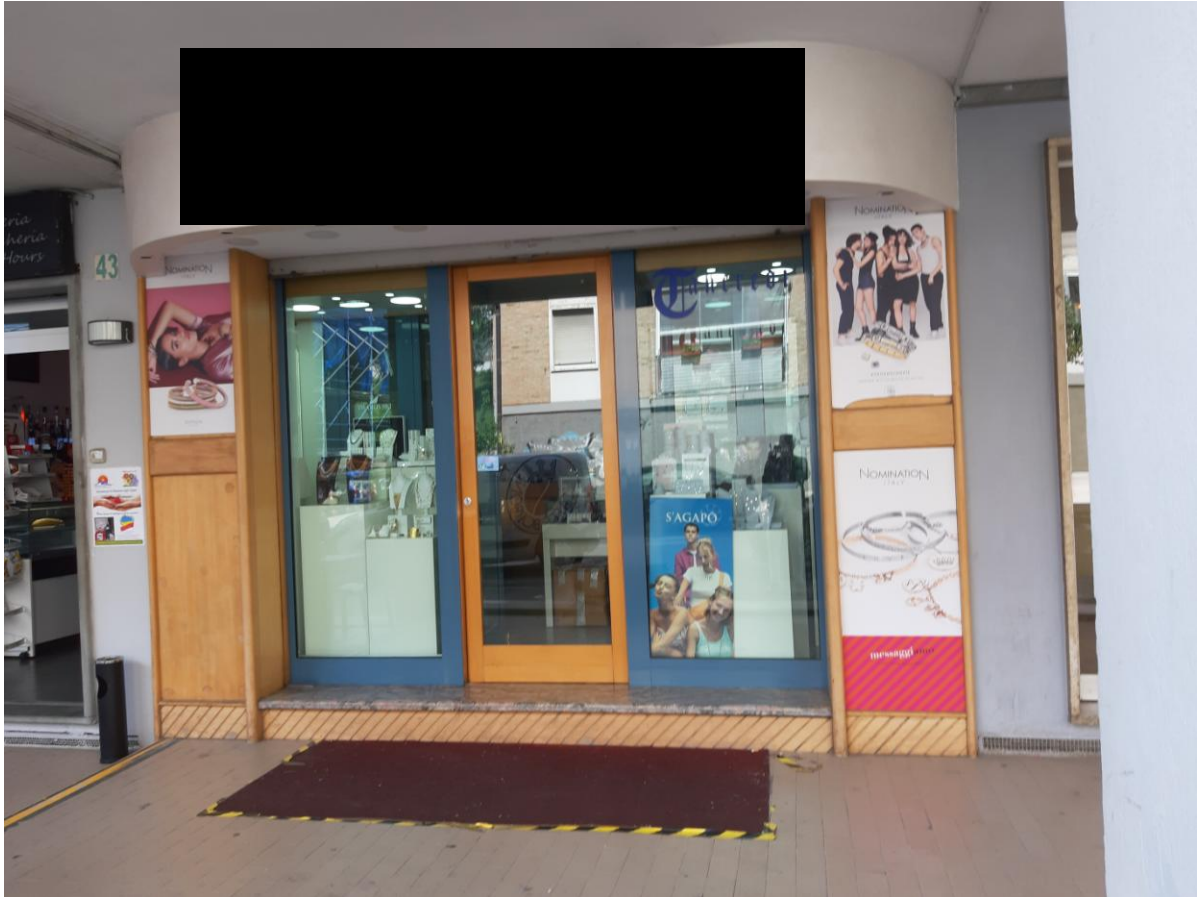
Figura 9 – Locale Commerciale Via Milano, n. 45.
