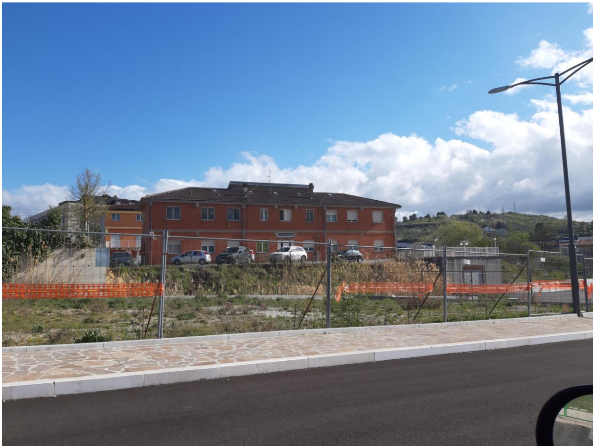
Figura 4 – Appartamento Via del Gallitello, n. 130.
