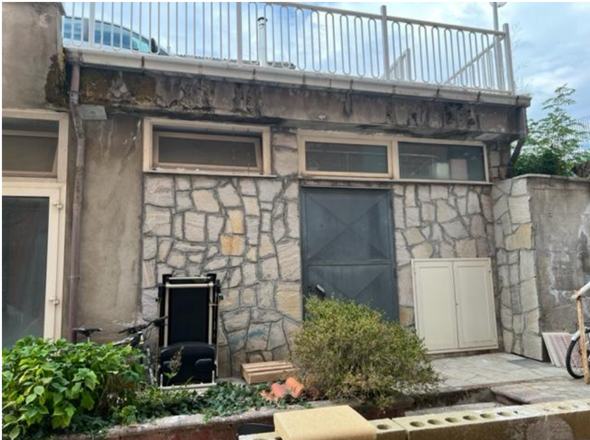
Figura 8 – Deposito Piano S1 Via del Gallitello, n. 130, foglio 46, p.lla 1235, sub 21.
