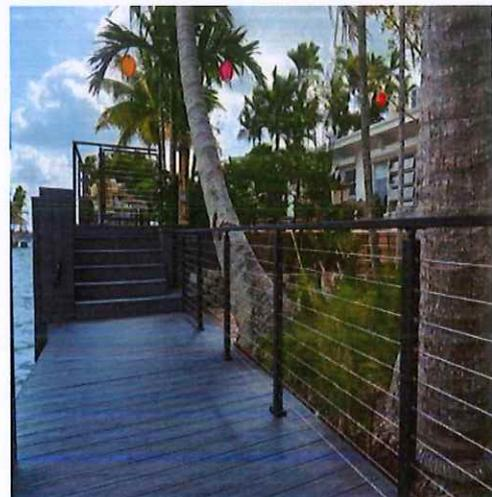
I parapetti esterni, qualora previsti, saranno realizzati con struttura in acciaio verticale verniciati e cavi in acciaio orizzontali equidistanti. Il corrimano sarà realizzato con profilato rettangolare in acciaio verniciato.
