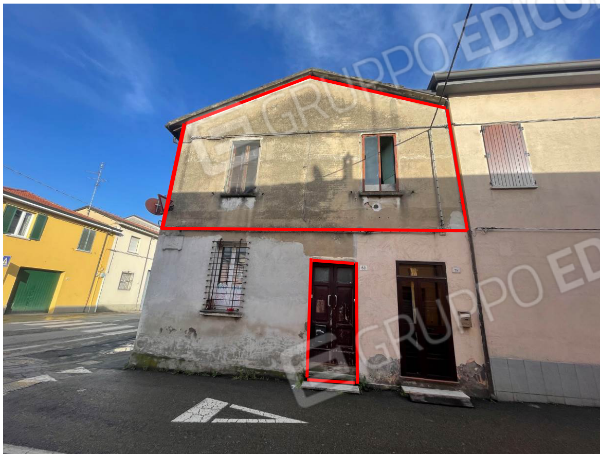
Via della Pace n. 60 – Massa Lombarda (Ra) - Vista esterna
