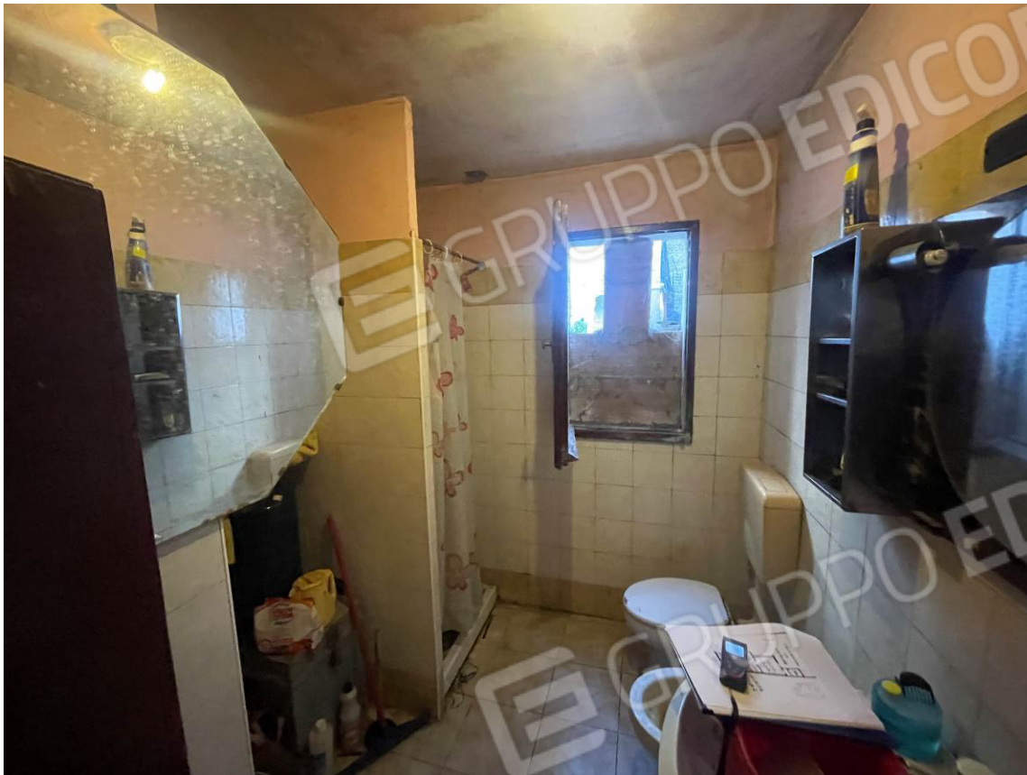
Via della Pace n. 60 – Massa Lombarda (Ra) – Sub. 9 – WC
