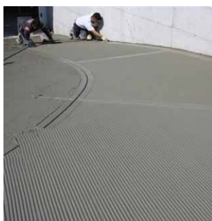
D1 - d _ Rampa corsello
