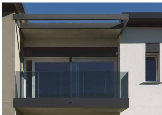
B1 - g _ Balconi con parapetti in vetro
