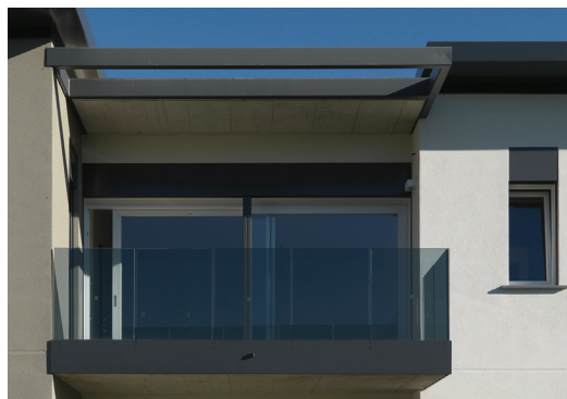
B1 - g _ Balconi con parapetti in vetro
