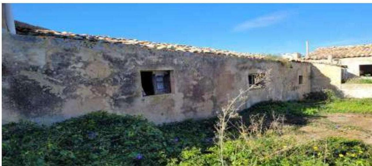
Così come rilevabile dalle foto si può affermare che i fabbricati descritti non sono in condizioni ottimali e non possono essere definiti utilizzabili nello stato attuale; tuttavia, si rileva che gran parte delle strutture portanti delle costruzioni sono, sotto l'aspetto statico, in discrete condizioni e non si evidenziano marcate lesioni strutturali.
