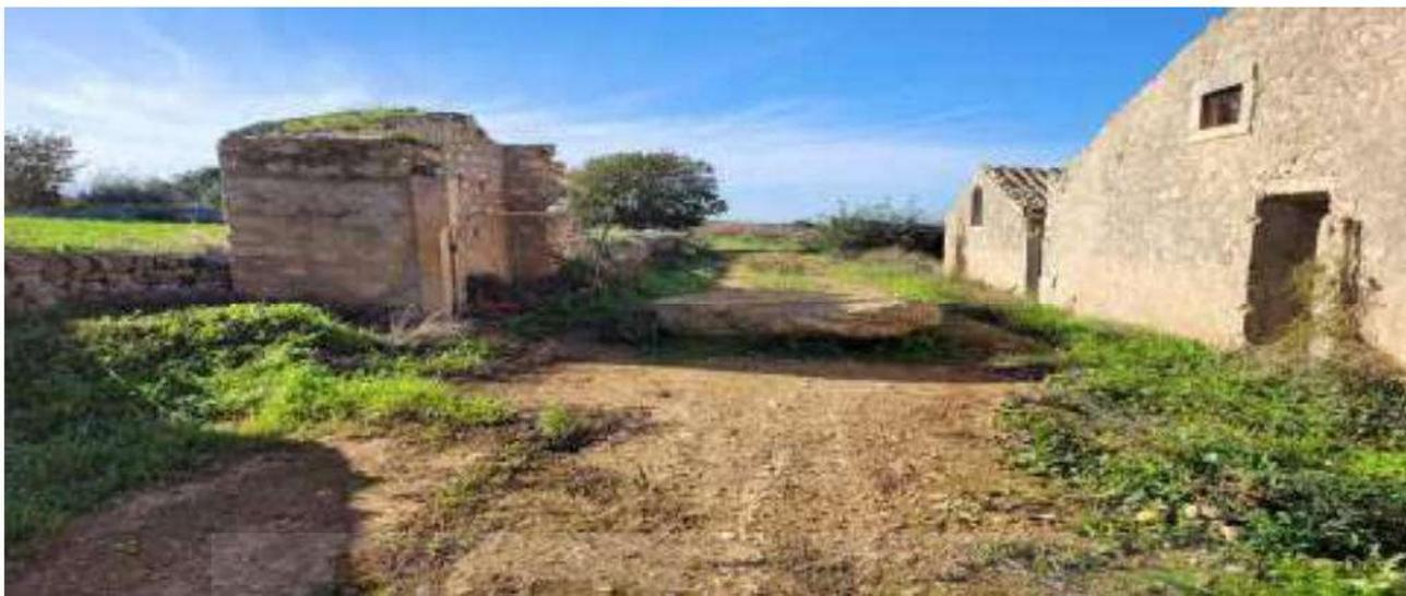
**Il fabbricato strumentale** identificato con il mappale n. 185 sub. 1 è costituito da un magazzino avente superficie di mq 82. Lo stesso presenta struttura portante in blocchi di calcare tenero, copertura in **lastre ondulate di cemento amianto (eternit)** su struttura portante in legno.
