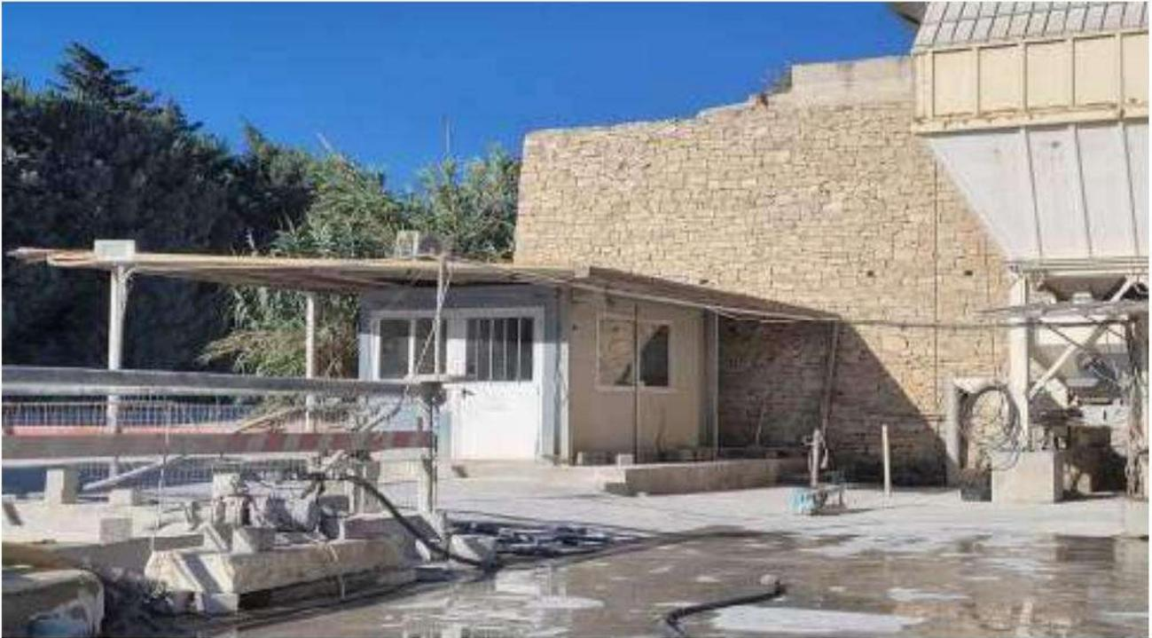
Locale tecnico in muratura al servizio dell'impianto di betonaggio, realizzato in laterizi forati e dotato di copertura piana in laterocemento, avente una superficie lorda di mq. 14.
