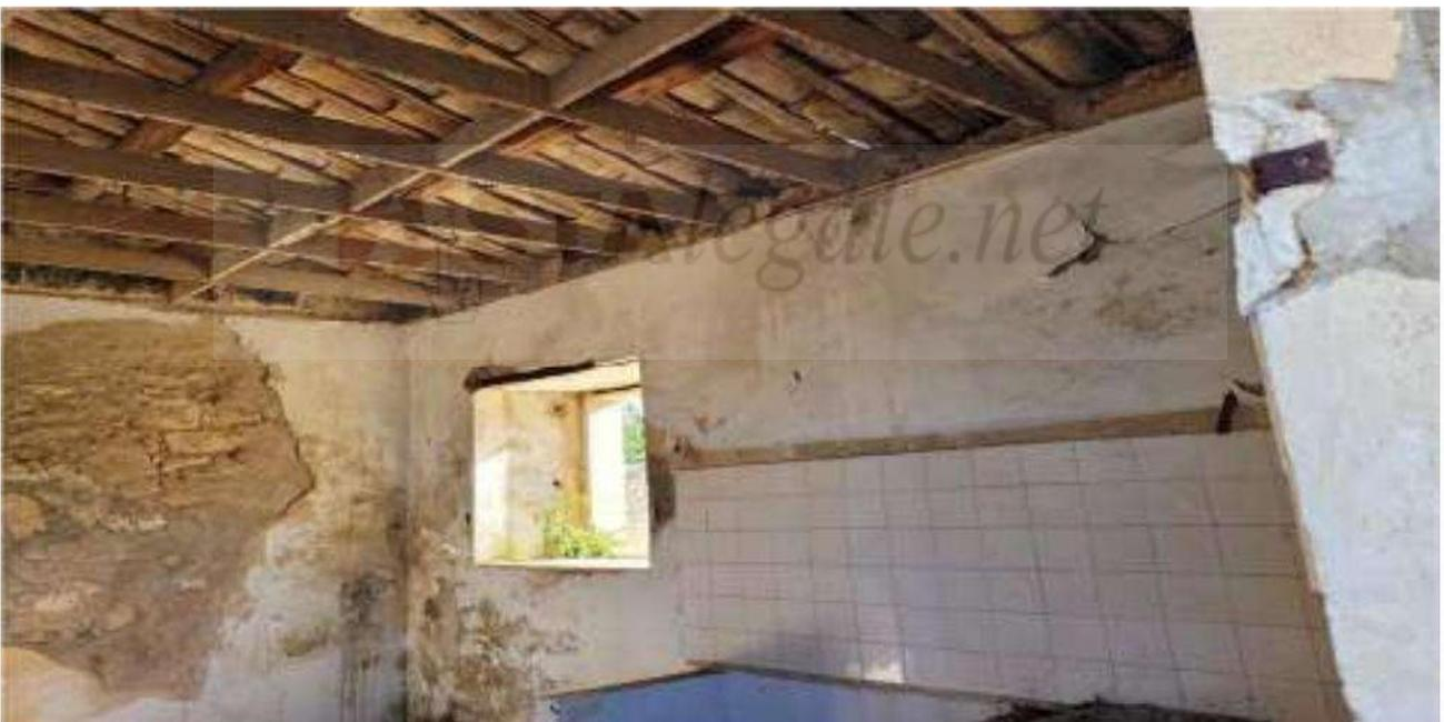
Le condizioni di manutenzione del fabbricato residenziale sono pessime, nello stesso si evidenziano dei cedimenti di alcune strutture portanti delle coperture, infissi in parte divelti ed in parte notevolmente deteriorati dal tempo e dagli agenti atmosferici, pavimenti, intonaci interni ed esterni sono in pessime condizioni di manutenzione. La costruzione disponeva di impianto elettrico esterno, attualmente non funzionante e di impianto idrico essenziale, di antica realizzazione.
