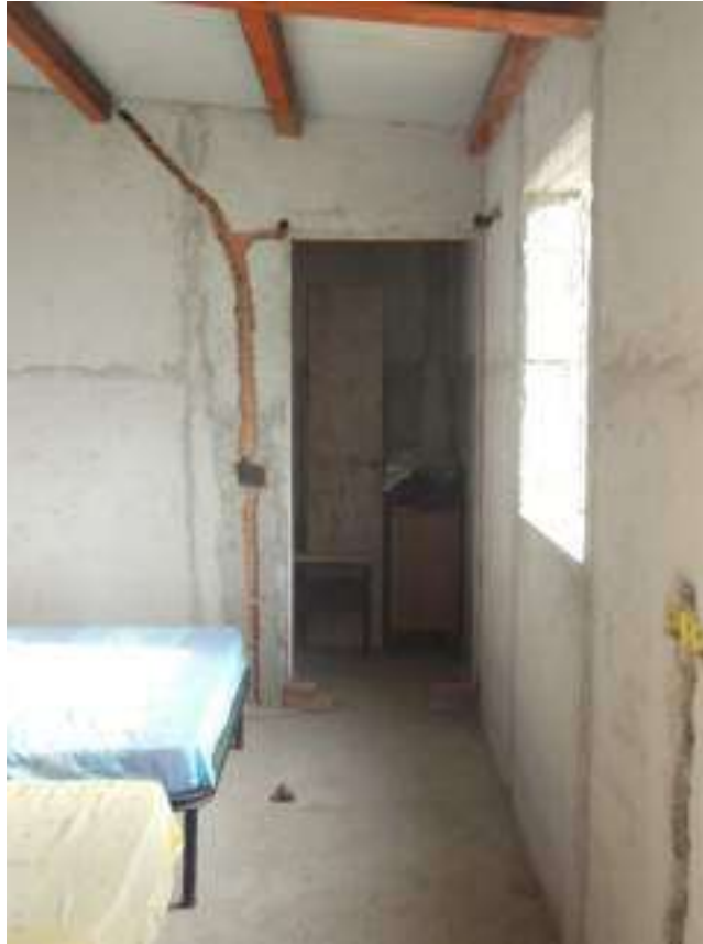
Parte del fabbricato priva di rifiniture
