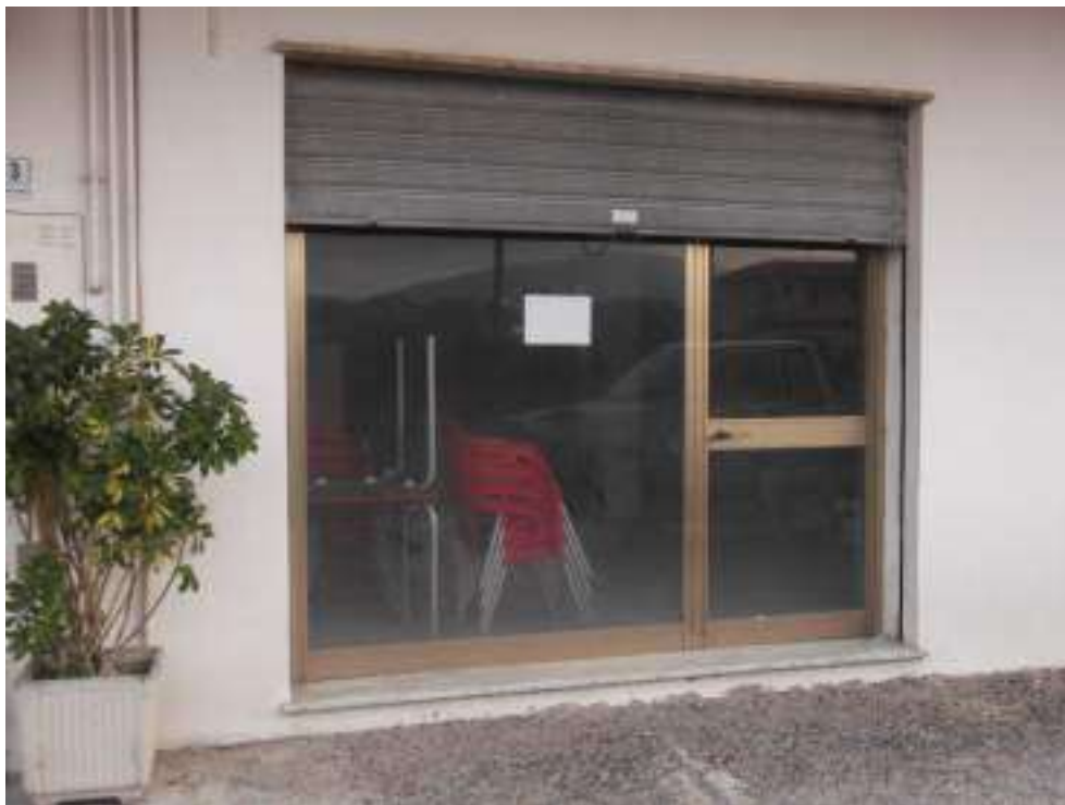
Ingresso Immobile B
