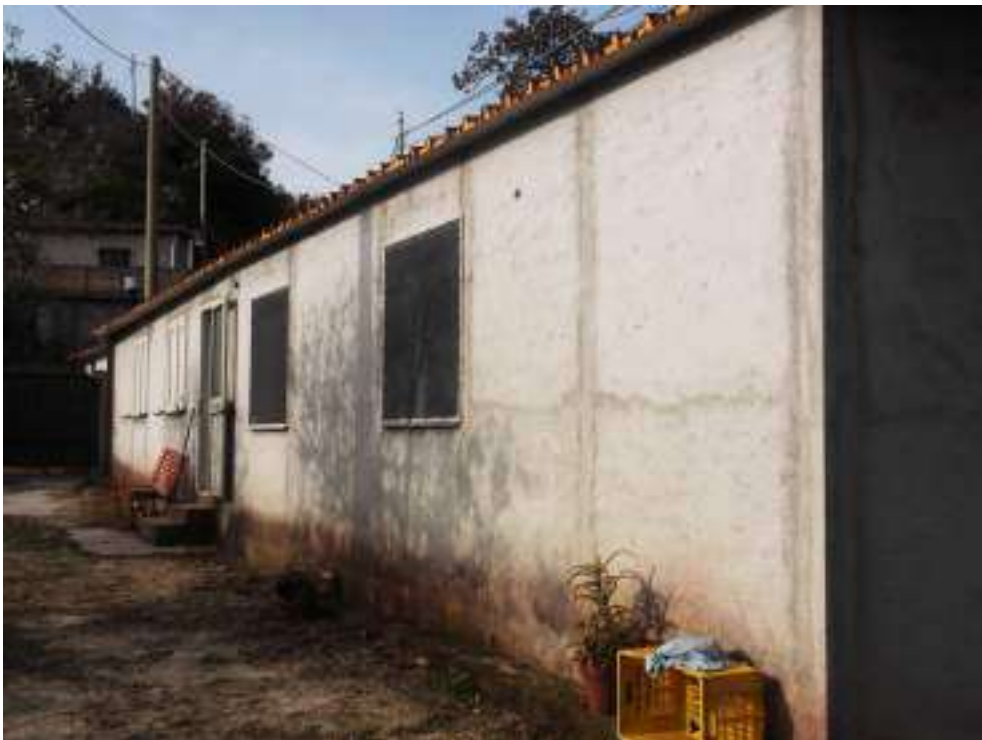
Fabbricato realizzato di circa 85 mq
