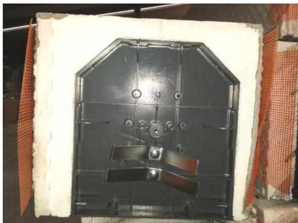
54. Fornitura e posa di **persiane avvolgibili a rullo motorizzate**, realizzati con profili in alluminio coibentati con poliuretano espanso ad alta densità ecologico per migliorare l'insonorizzazione e l'isolamento termico, fornite e poste in opera, compreso ogni onere per il corretto funzionamento con apertura – chiusura elettrica co dispositivo a uomo presente; le guide fisse in acciaio zincato a U, colore RAL standard a scelta della D.L..
