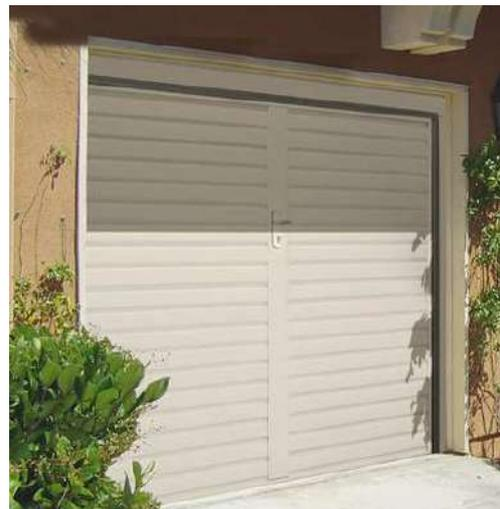
60. Fornitura e posa tra il garage e il locale disimpegno di **porta tagliafuoco EI 60** (per locali fuori-terra) realizzata con doppia lamiera zincata e verniciata in tinta RAL 9018 (bianco papiro), con interposto materiale coibente ad alta densità, completa di cerniere, serratura a cilindro tipo Yale e maniglia antinfortunistica colore nero.
