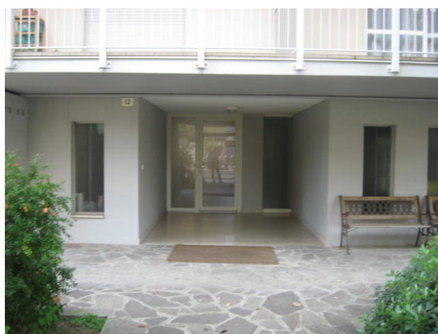
Ingresso comune e prospetto posteriore
