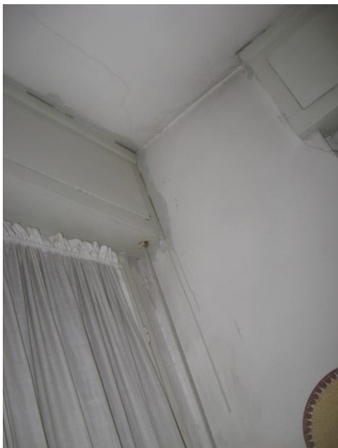
Particolare vani di abitazione
