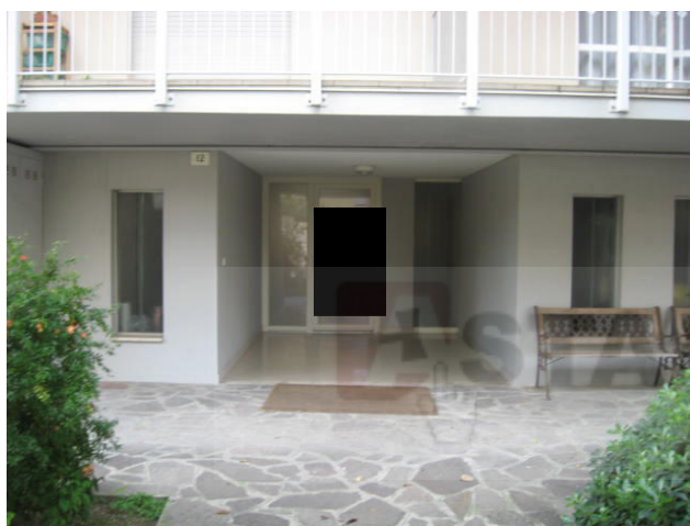
Ingresso comune e prospetto posteriore
