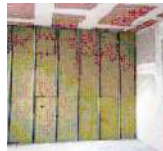
Controsoffitti in cartongesso Coibentazione interna pareti divisorie e perimetrali
