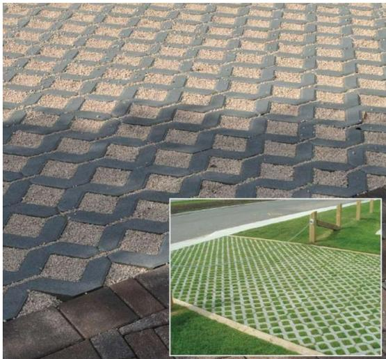
Figura 48 - Pavimentazione tipologica per le aree parcheggio
