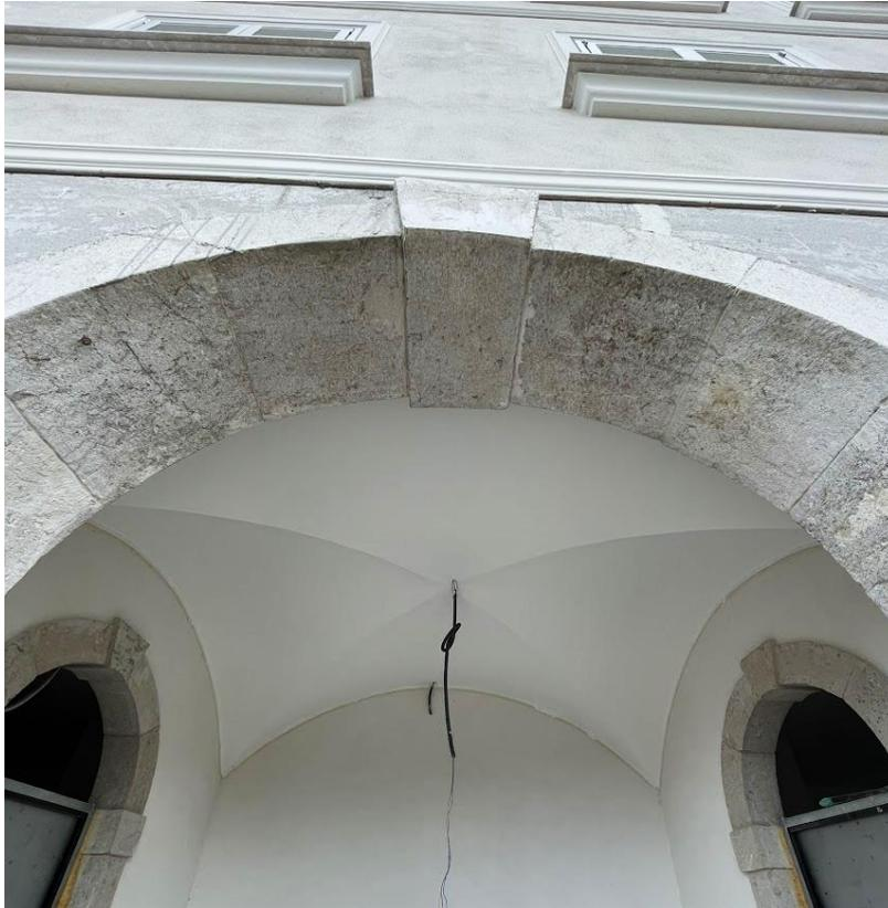
*Figura 35 - Dettaglio ricostruzione volta a crociera e archi di ingresso – fase di cantiere*
