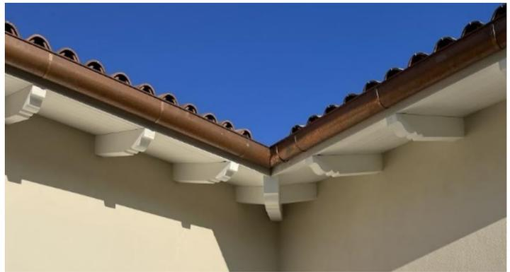
Figura 6 – Vista esterna su dettaglio travi della copertura
