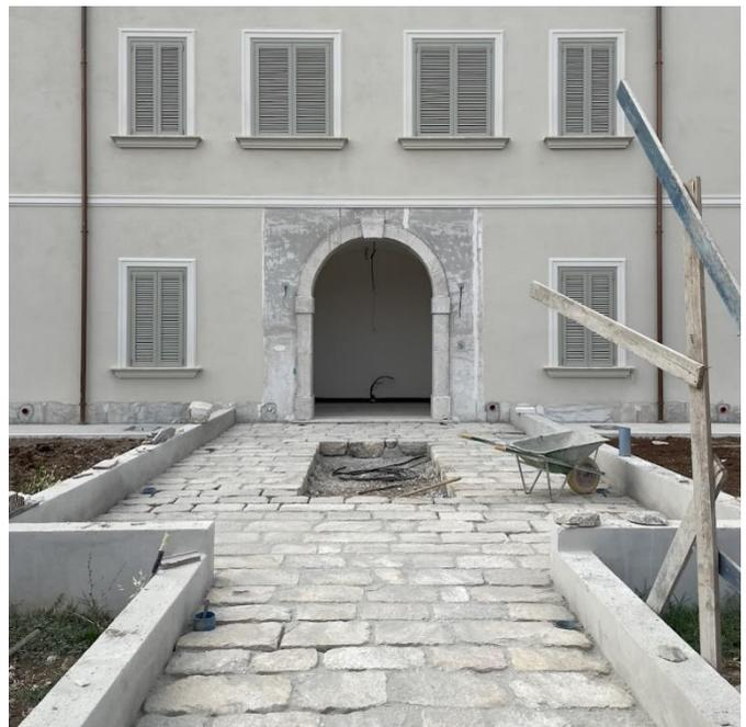
*Figura 34 - Ricostruzione della pavimentazione in basolato - fase di cantiere*
