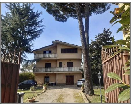
la scala comune di un edificio per civile abitazione composto complessivamente da tre appartenenti. L'edificio è costruito in muratura portante su fondazione continua, ha i solai latero-cementizi, copertura a falde e manto in coppi laterizi. Balconi a sbalzo, scala comune ed architravi delle finestrature in cls.a..
