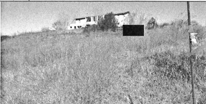
Terreno edificabile - Porzione Ovest (p.lle 619, 620, 621, 622, 623, 624) – Vista da Sud-Est
