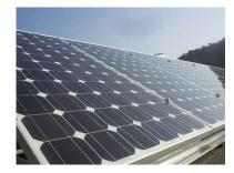
È prevista l'installazione di un impianto fotovoltaico in grado di produrre energia elettrica. Questo sistema consente di trasformare direttamente e istantaneamente l'energia solare in energia elettrica senza l'uso di alcun combustibile. L'impianto fotovoltaico inoltre non necessita di grandi operazioni di manutenzione.
