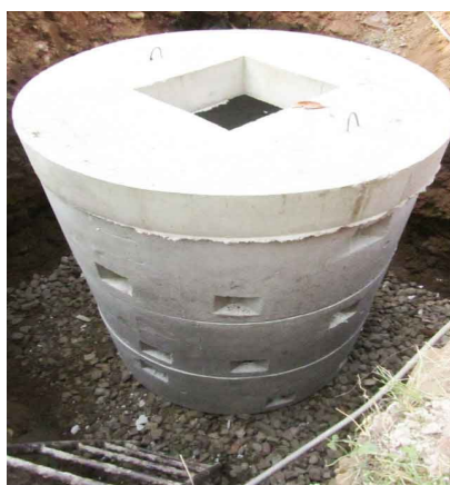
esempio pozzettone CLS accumulo acqua meteoriche
