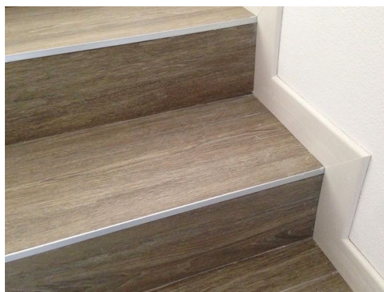
esempio realizzazione scala gress
