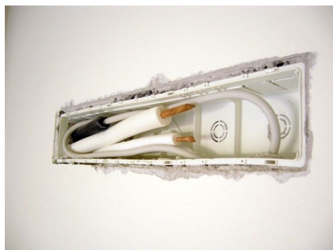
esempio predisposizione impianto condizionamento
