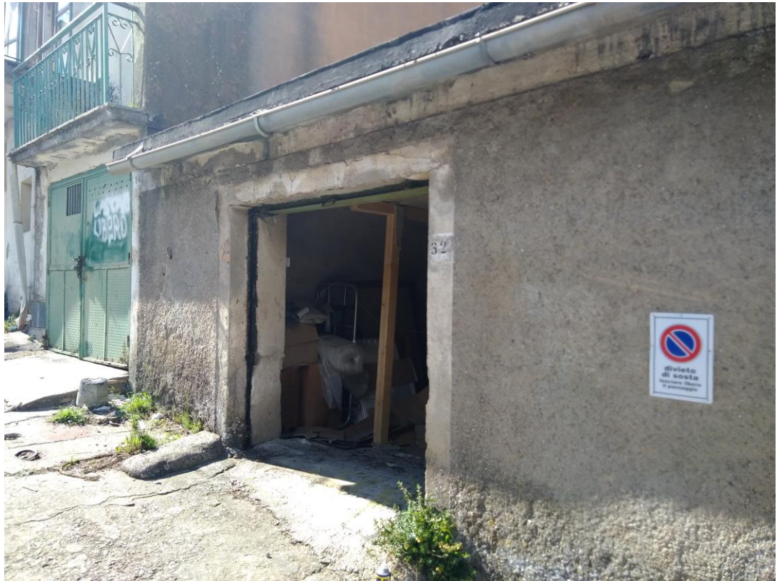
FOTO 7- Vista ingresso magazzino – civico 32
