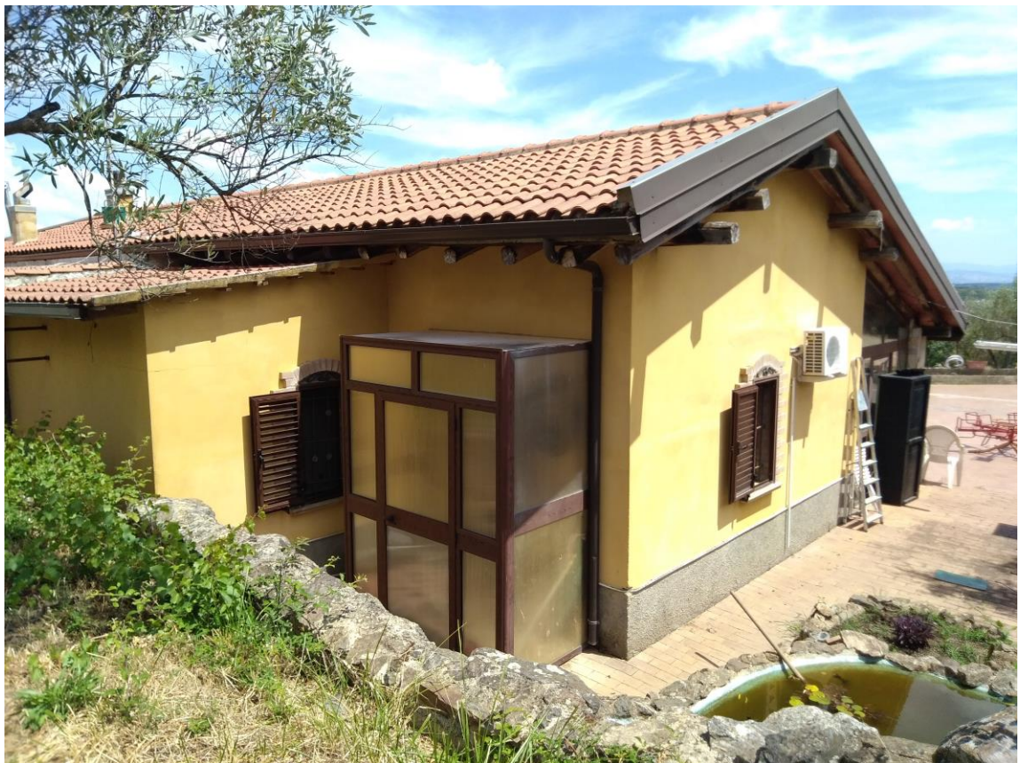
FOTO 5 – vista lato est del fabbricato
