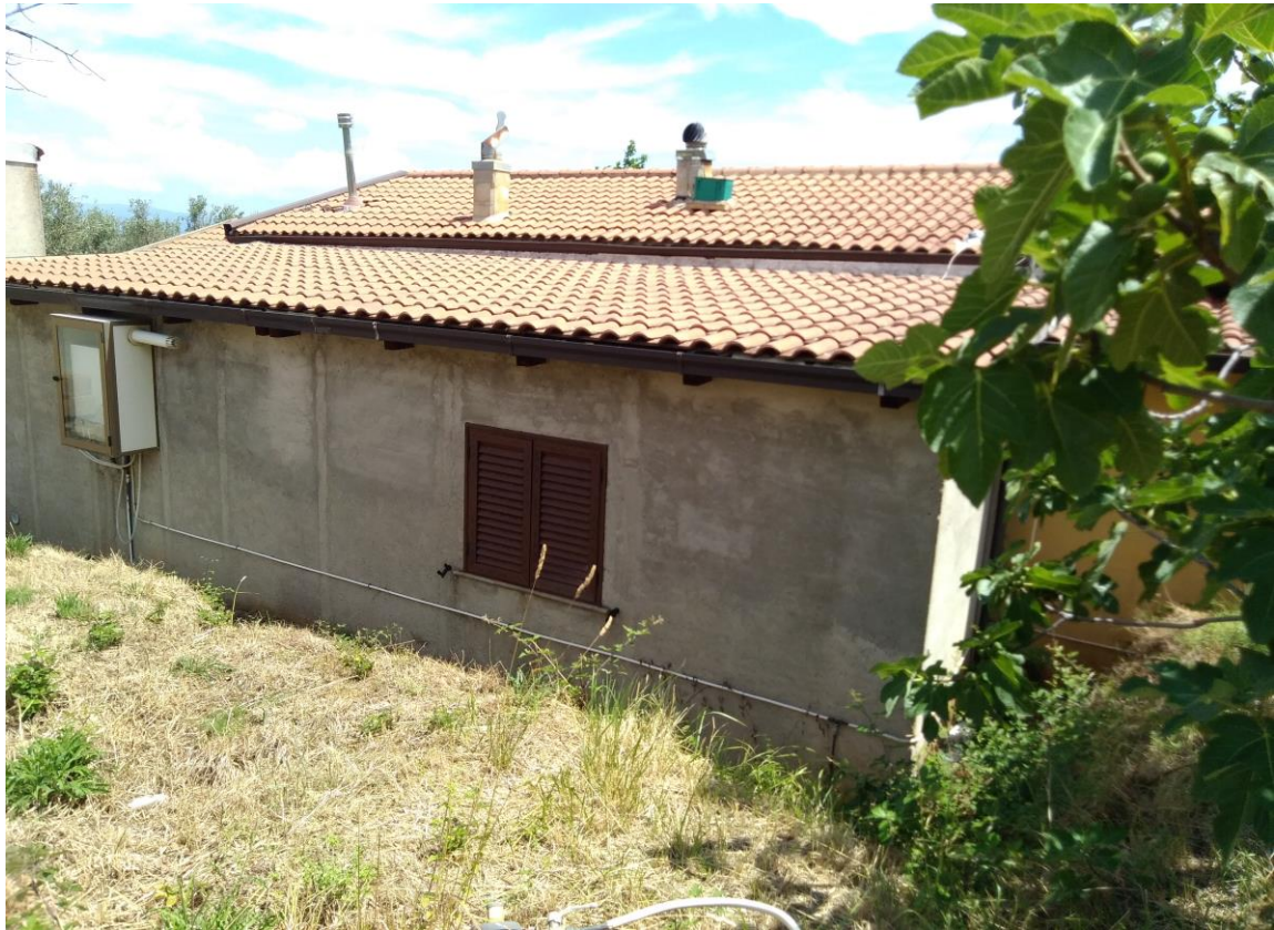
FOTO 4 – vista lato ovest del fabbricato
