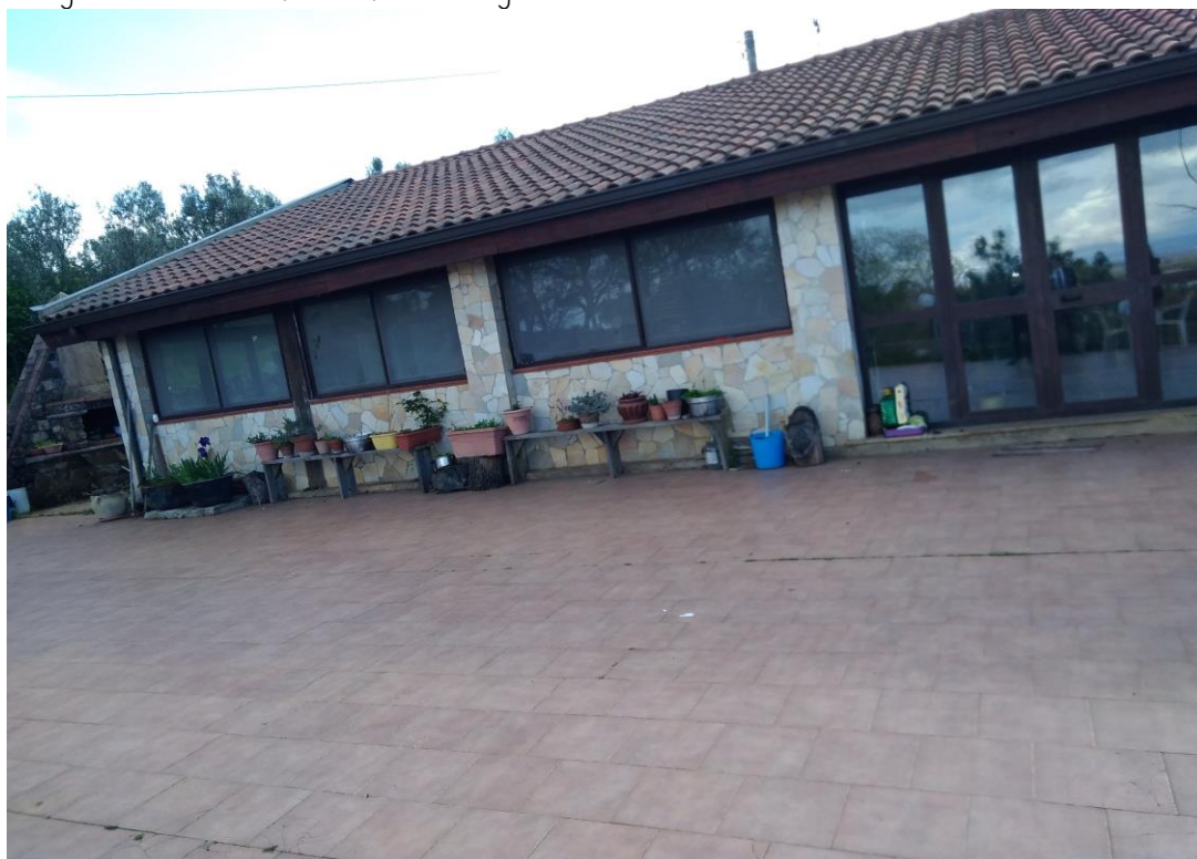
FOTO 1 - Vista dell'ingresso principale – lato est del fabbricato
