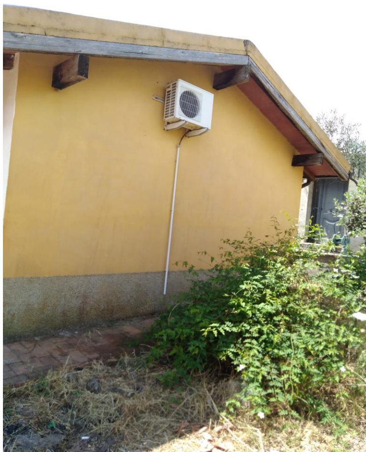
FOTO 3 – vista lato nord del fabbricato
