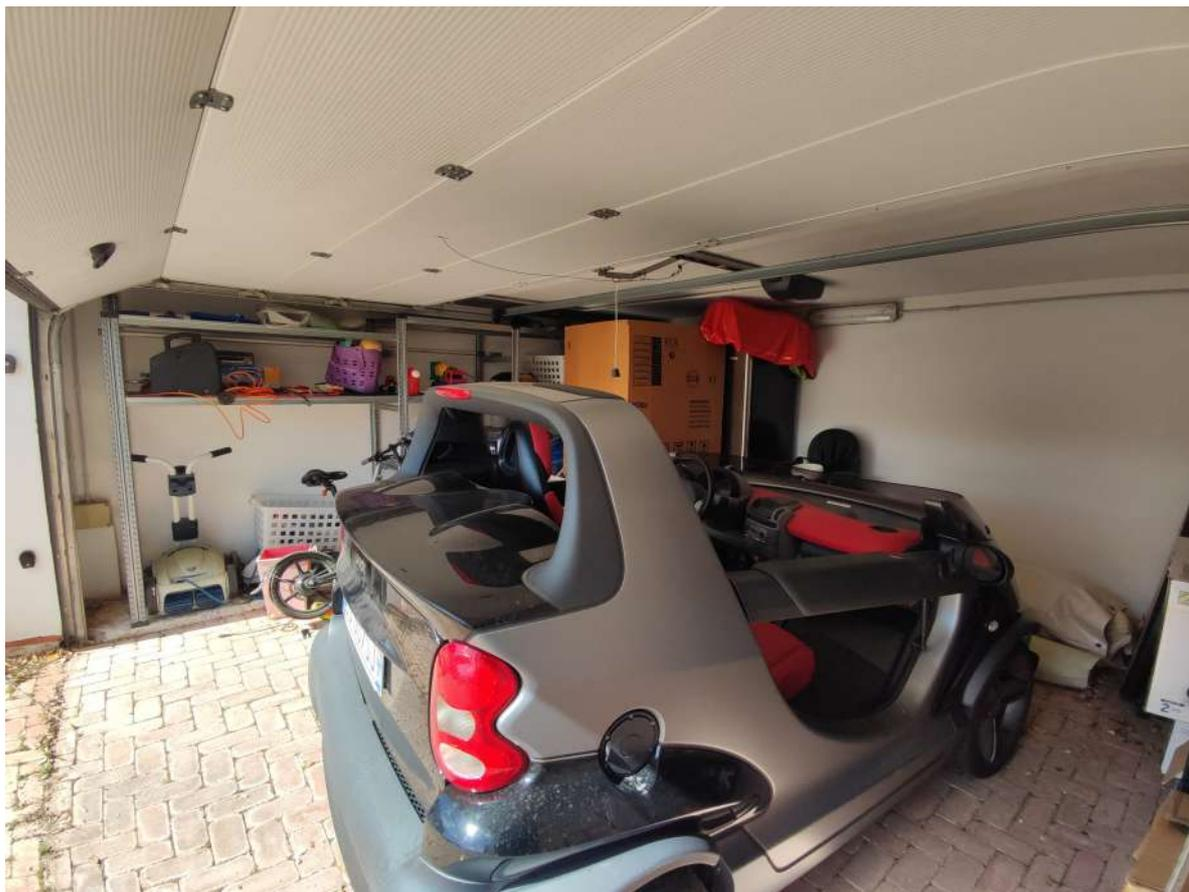
Lo stato di finitura e conservazione degli spazi interni è discreto nella manutenzione e conduzione. I pavimenti sono realizzati in autobloccanti, le pareti sono intonacate al civile e pitturate con tempera bianca.
