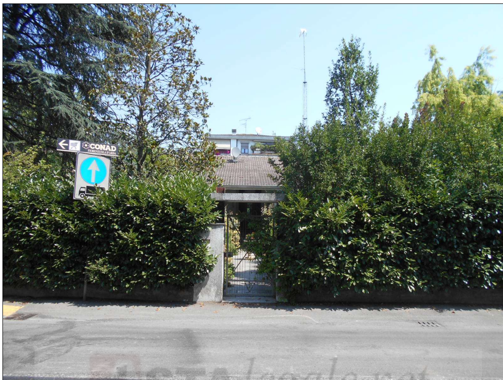
1 Ingresso pedonale dalla strada
