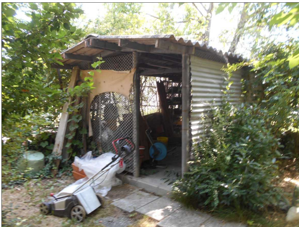
12 Manufatto spigolo nord est del lotto
