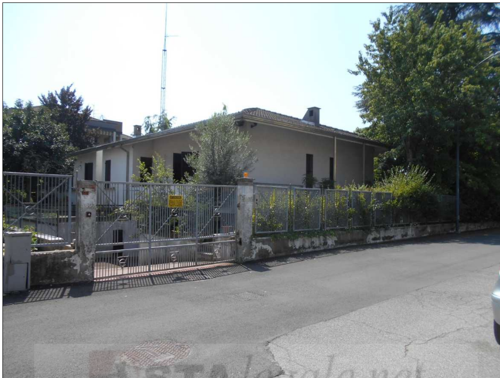
3 Scorcio lotto dalla strada (nord ovest)
