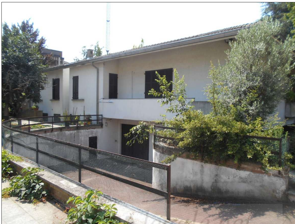
7 Scorcio rampa carrabile (nord ovest)
