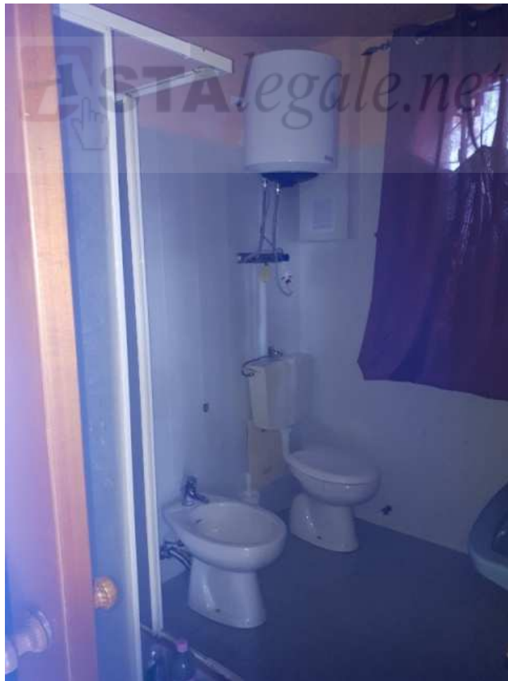
FOTO BENE B.1 – Interno locale di deposito (sub 4)
