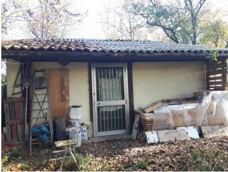
FOTO BENE B.2 – Deposito piano terra (sub 5), prospetto ovest
