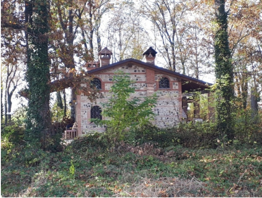
FOTO BENE B.1 – Deposito piano terra e primo (sub 4), prospetto est
