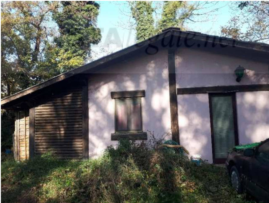
FOTO BENE B.2 – Deposito piano terra (sub 5), prospetto sud
