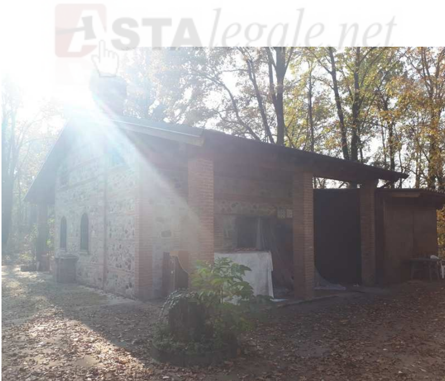
FOTO BENE B.1 – Deposito piano terra e primo (sub 4), prospetto nord-est
