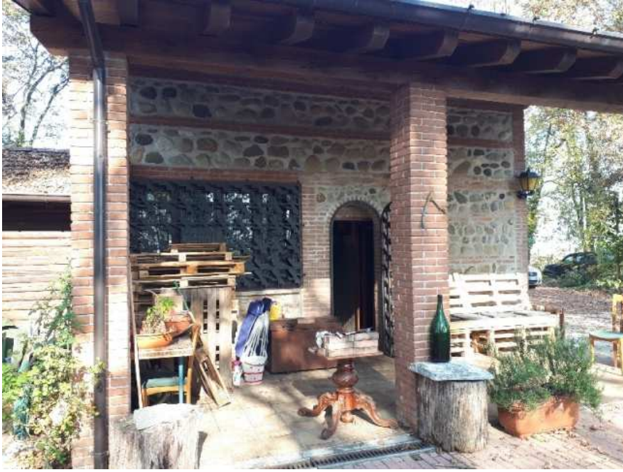
FOTO BENE B.1 – Deposito piano terra (sub 4), prospetto sud
