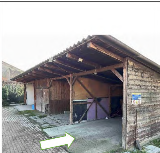
Figura 7 - vista tettoia autorimesse
