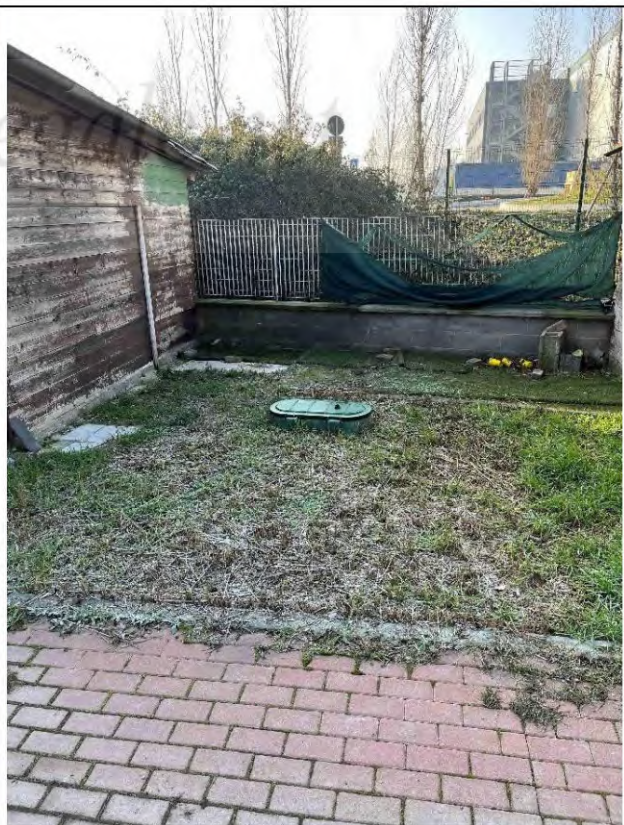
Figura 9 - corsello condominiale con vista su bocchettone del bombolone del GPL
