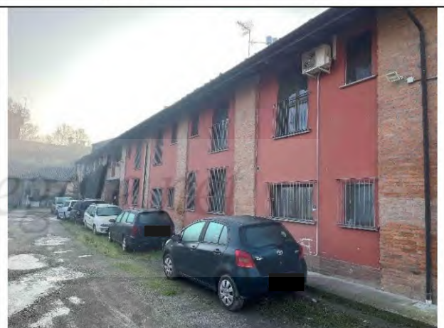
Figura 5 - vista stradello di accesso lato nord
