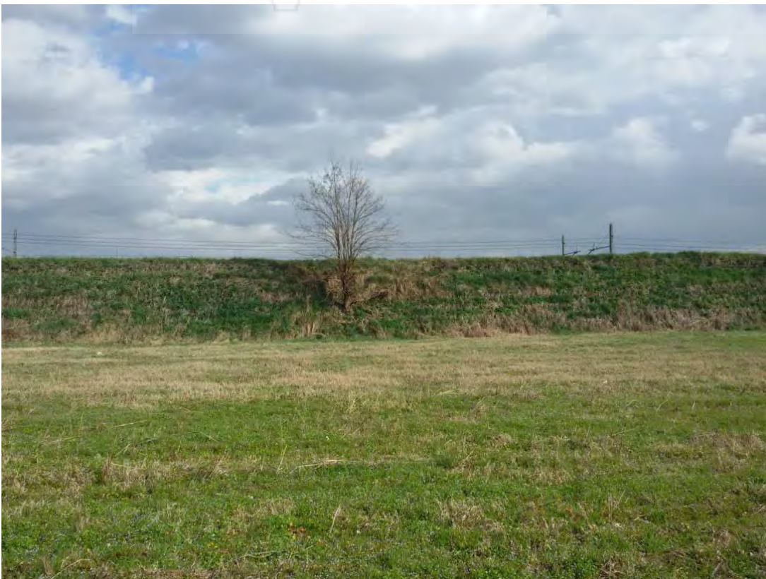
12. Area convenzionata – barriera antirumore.
