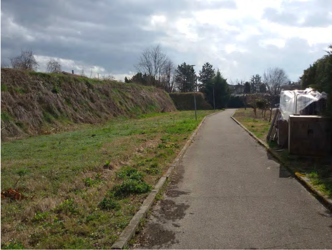
13. Area convenzionata – barriera antirumore.
