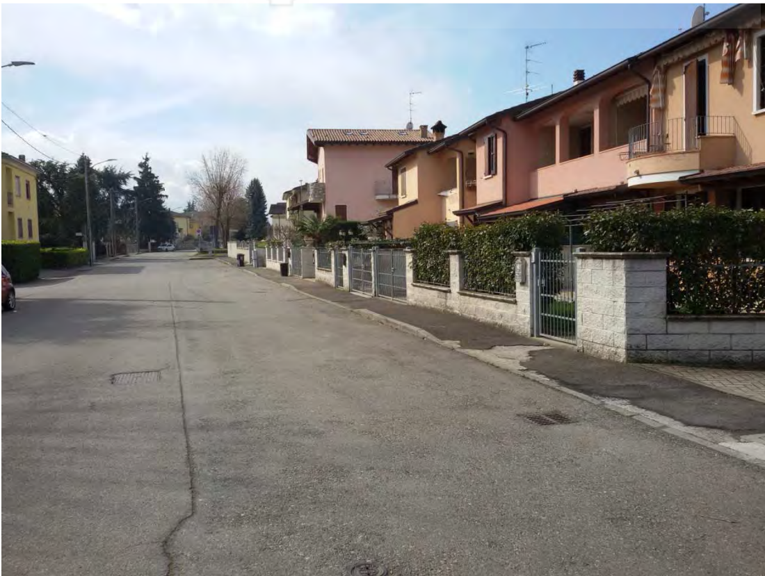
16. Area convenzionata – parcheggi e marciapiede.
