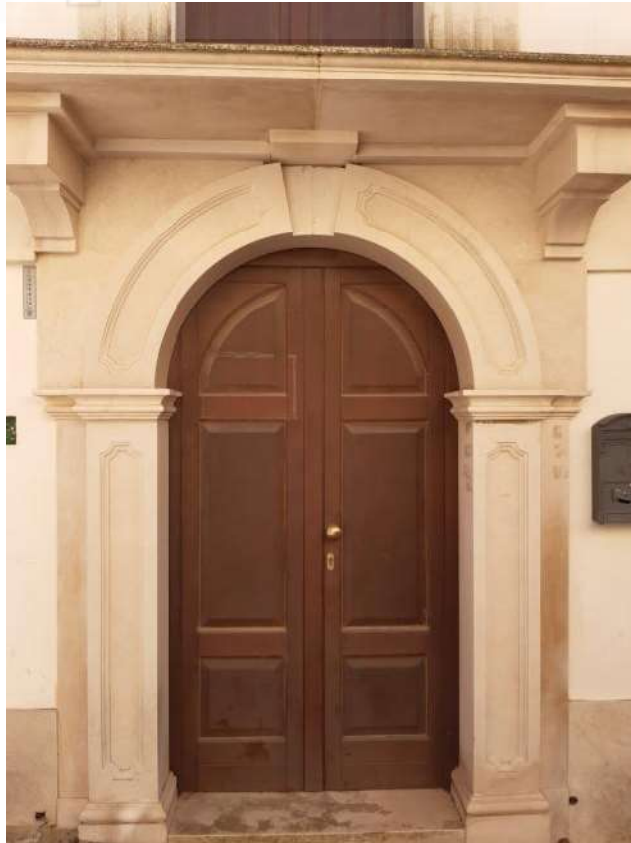
Vista n.4 – Porta d'ingresso via S. A. Guastella N.68 –
