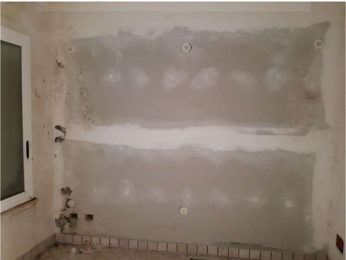
Vista n.16 – Locale di servizio (piano terzo sottostrada) –
