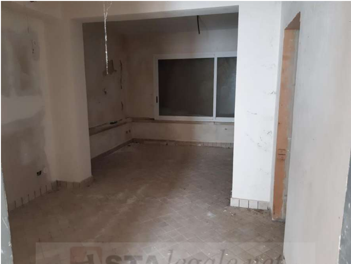
Vista n.15 – Locale di servizio (piano terzo sottostrada) –
