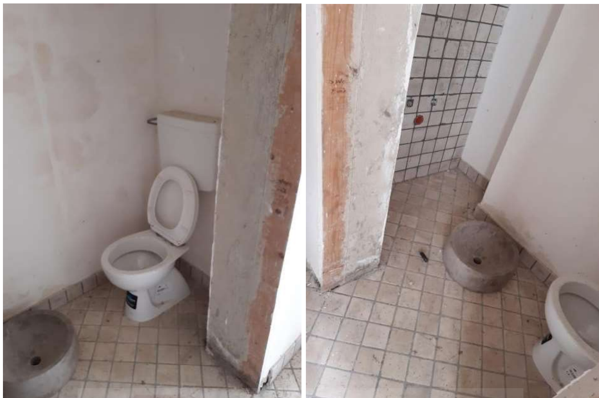
Vista n.17 – W.C. (piano terzo sottostrada) –
