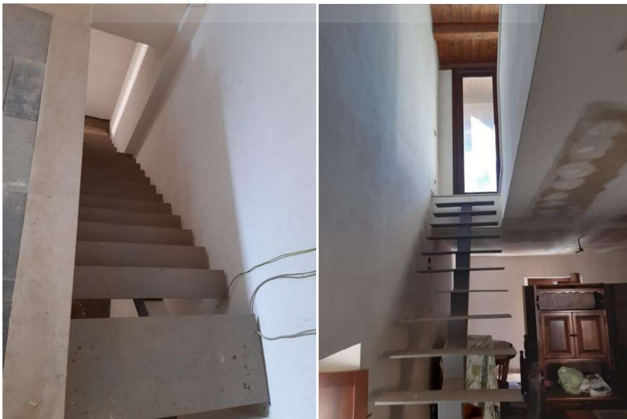
Vista n.6 – Scala interna –
