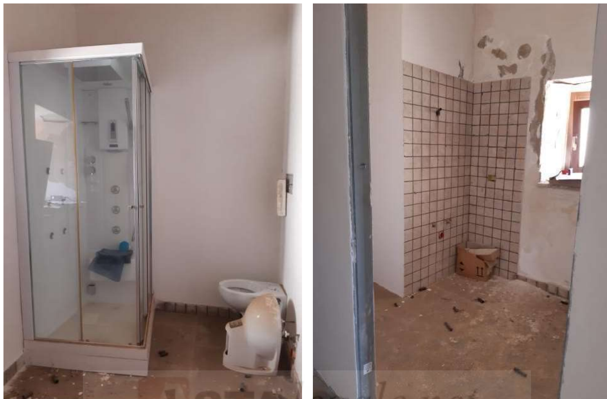
Vista n.11 – Bagno (piano primo sottostrada) –
