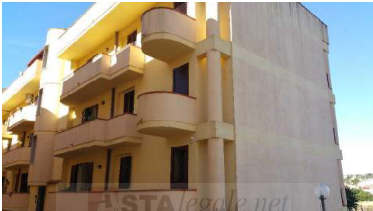
FOTO 1 PROSPETTO SUD APPARTAMENTO
