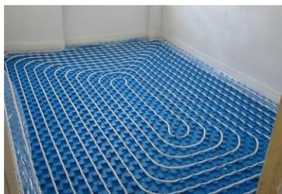
Costituito da riscaldamento a pavimento realizzato con tubazione del tipo multistrato-Pex e pannello del tipo a bugne in EPS.
