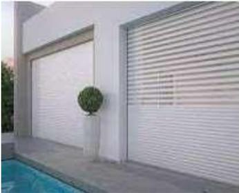
Le **TAPPARELLE** saranno in alluminio ad azionamento elettrico di colore a scelta della D.L.
